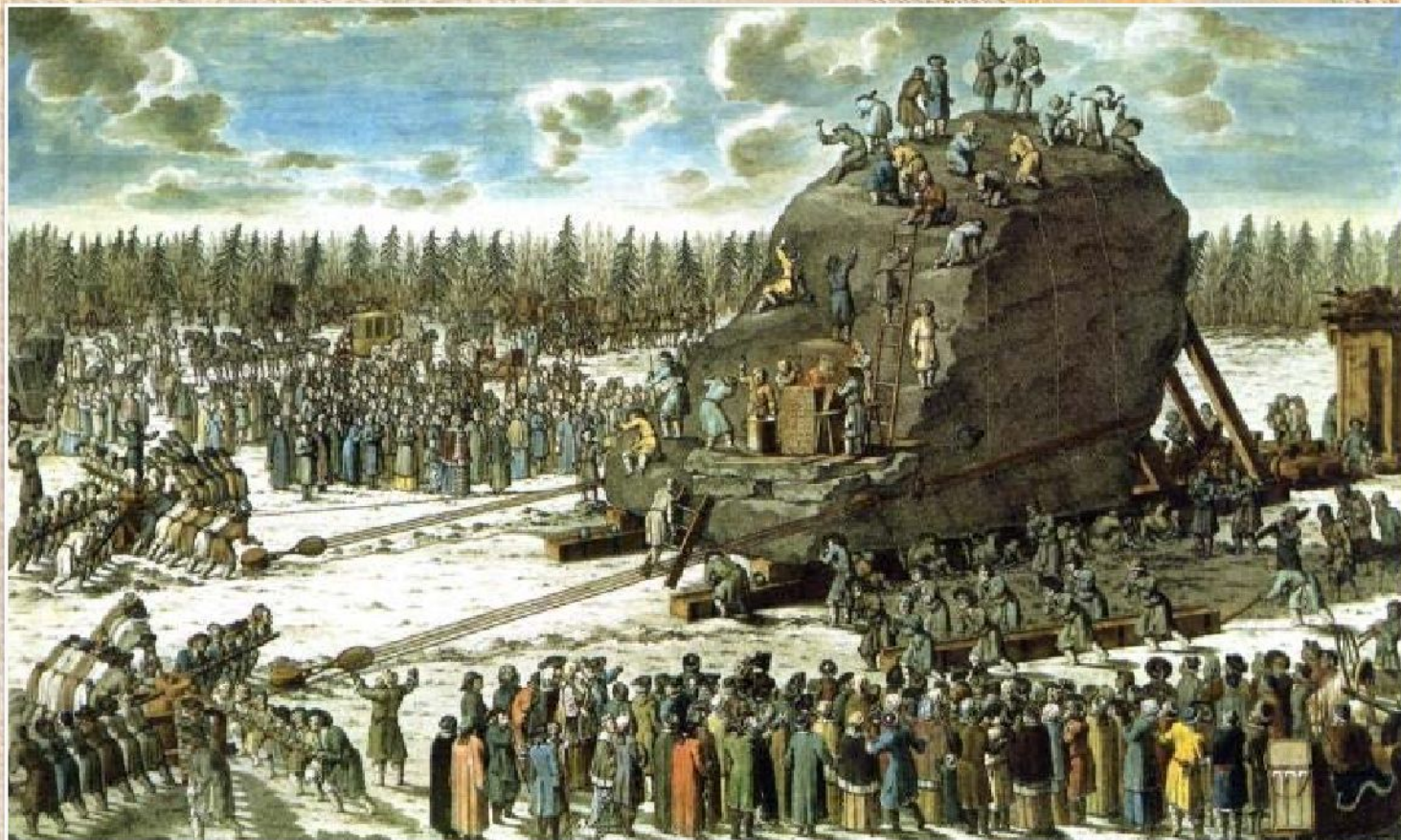
Транспортировка «Гром-камня» для пьедестала монумента «Медный всадник» (вес 2400 тонн, Санкт-Петербург, 1769-1770 )
