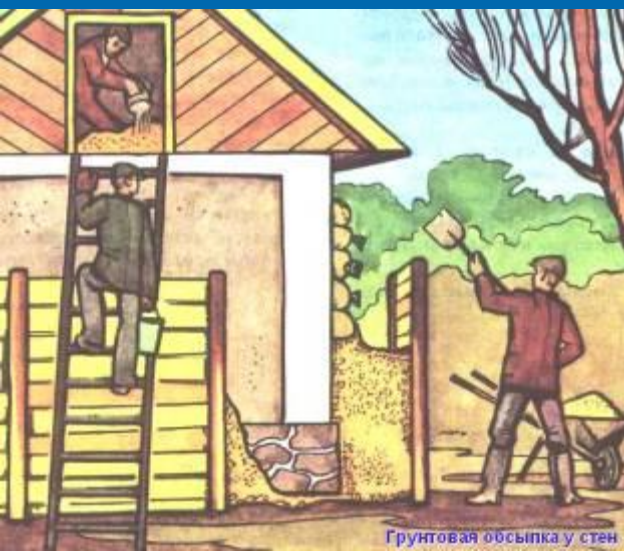
Грунтовая обсыпка у стен
