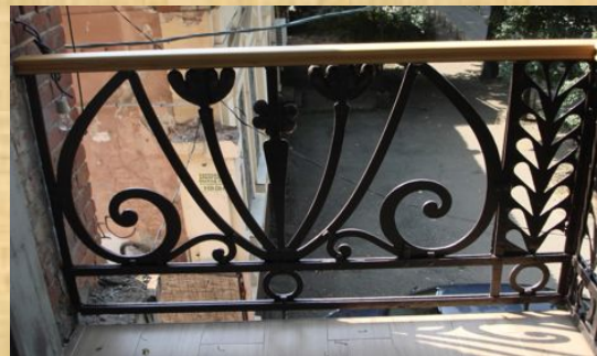
Кованое ограждение балкона 2 этажа
