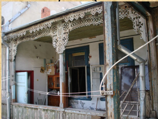
Деревянные резные элементы декора террасы
