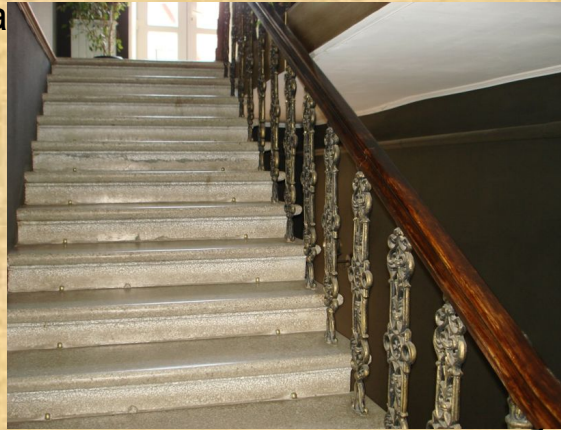
Парадная лестница с мозаичными бетонными ступенями, чугунным ограждением и деревянным поручнем
