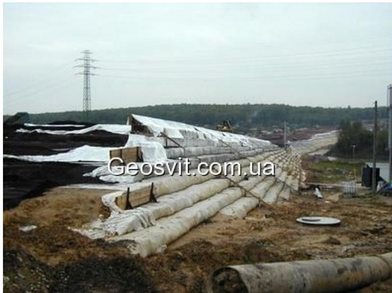
**Геотекстиль** – водопроницаемое полотно, полученное из скрепленных между собой полипропиленовых или полиэфирных мононитей. Изготавливается из натуральных или искусственных полимеров путем механического, либо термического сцепления нитей или волокон.
