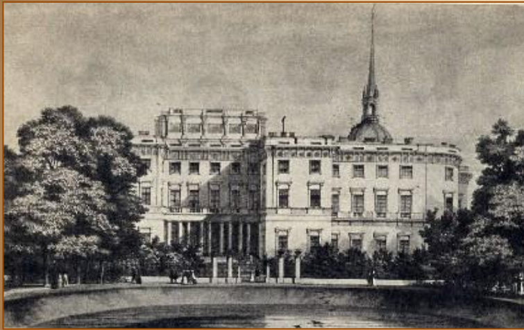
Главное инженерное училище (Инженерный замок)
