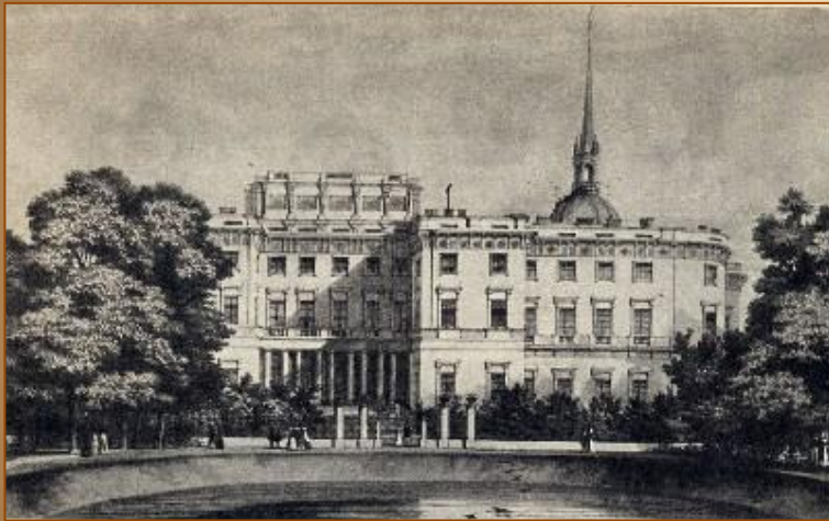
Главное инженерное училище (Инженерный замок)
