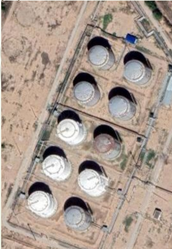
Рис 2 : Эксплуатируемые резервуары с оборудованными нефтепроводами
