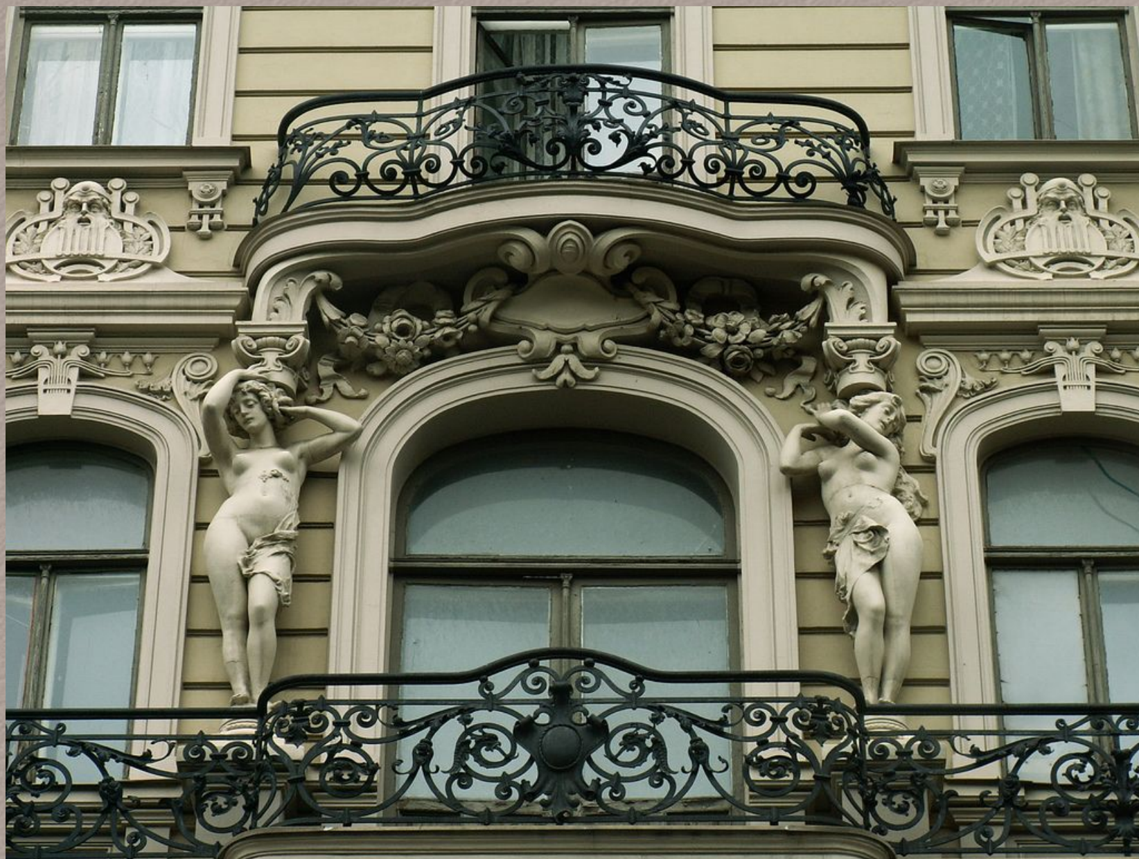
Рига. Латвия. Архитектор Михаил Эйзенштейн
