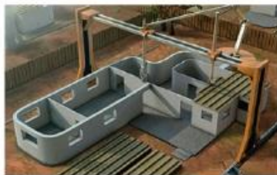
Рис. 9.42. Применение 3D-принтеров в строительстве
