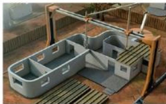
Рис. 9.42. Применение 3D-принтеров в строительстве
