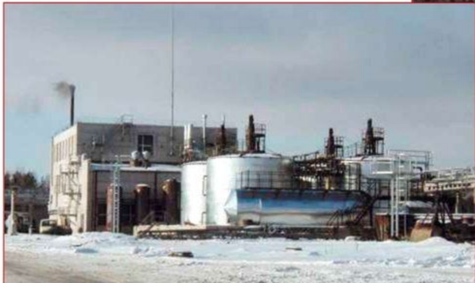
Корпус переработки жидких органических отходов на полигоне «Красный Бор»
