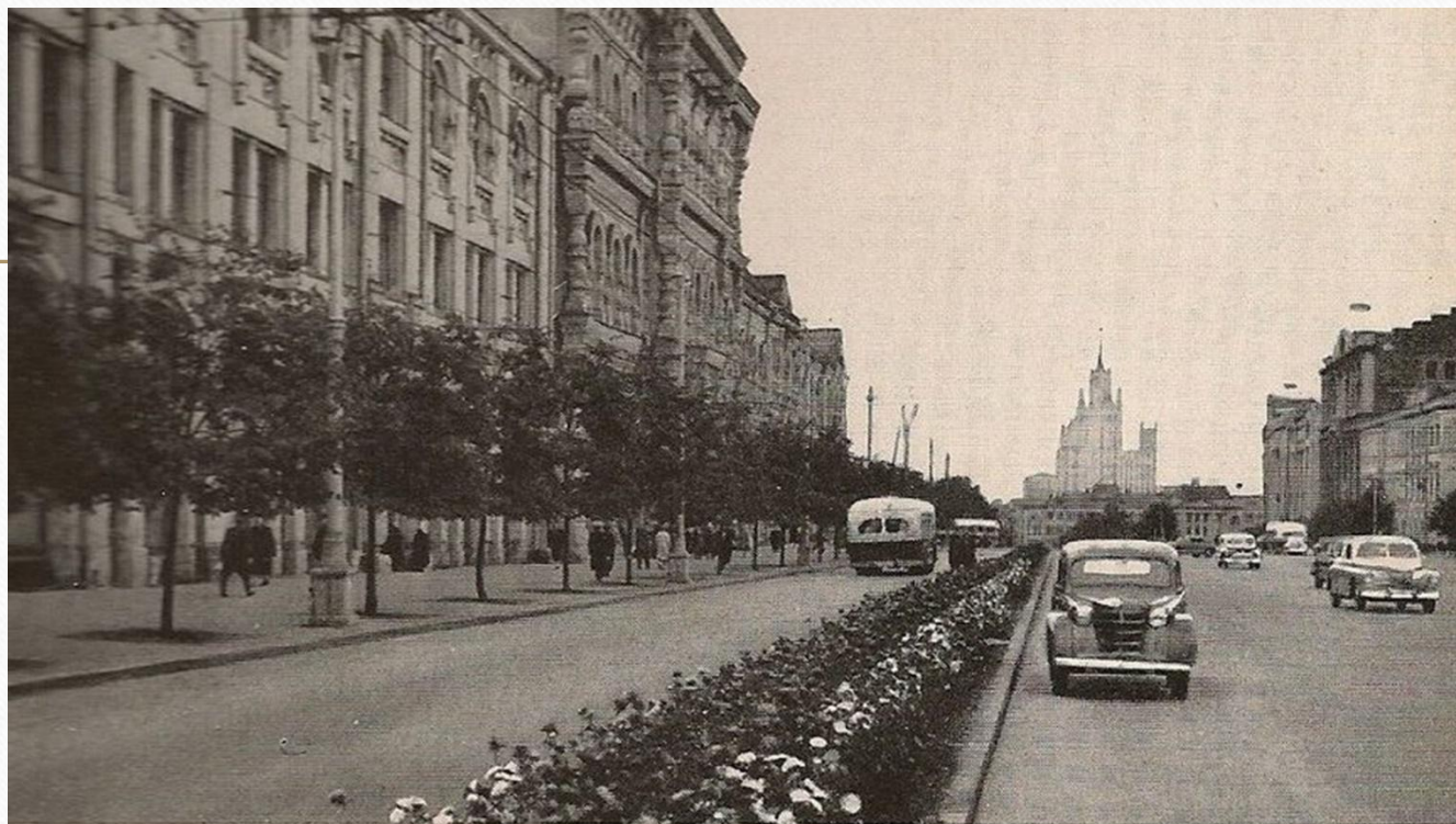
Зеленые насаждения на Новой площади, 1956 г. Фото 1957 г. Verdure de la place Novaïa, 1956. Photo 1957
