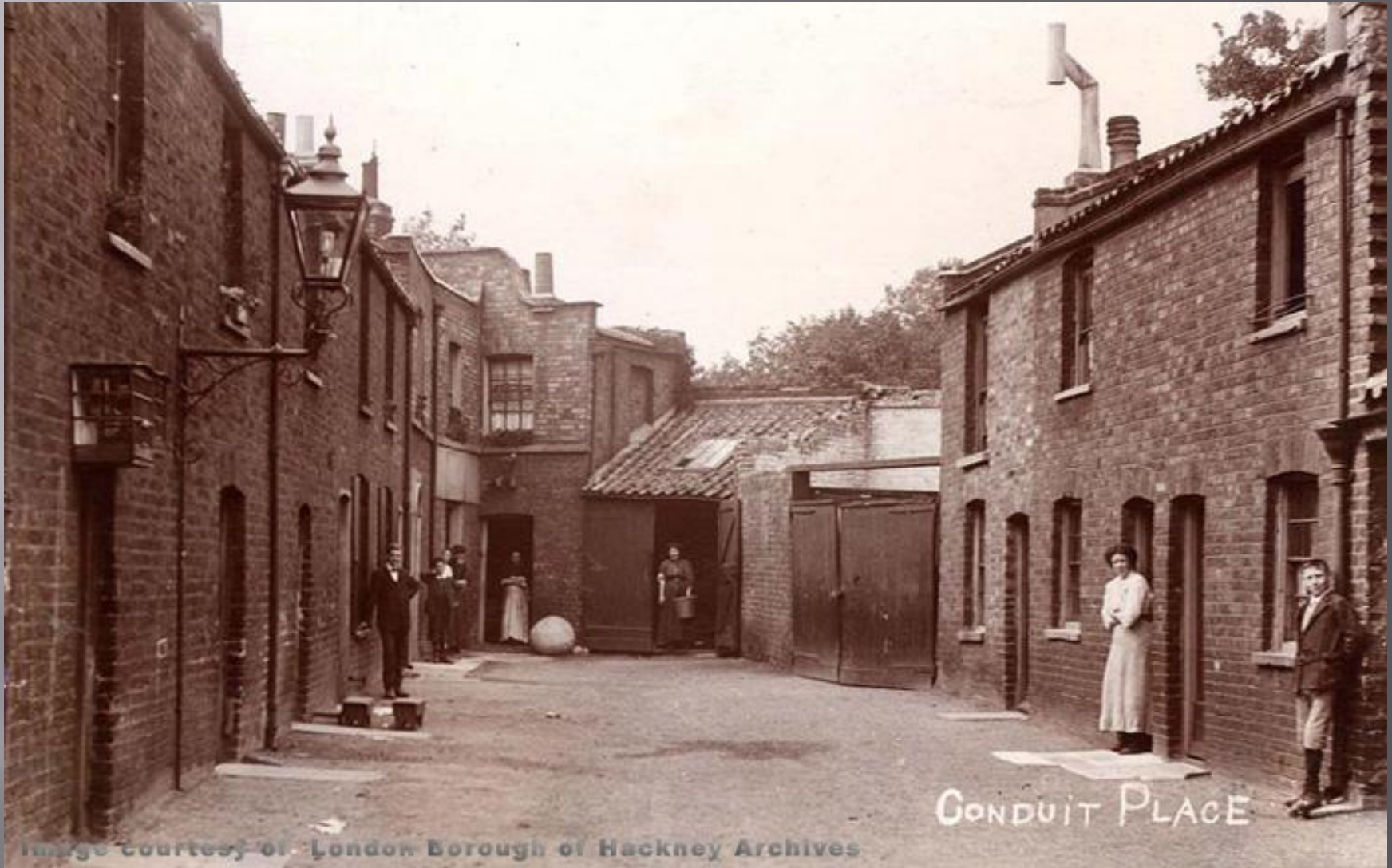
Caroline Cottages, Conduit Place
