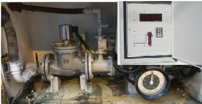
Данный вариант позволяет выдавать требуемую дозу топлива в точности до 20 грамм.
