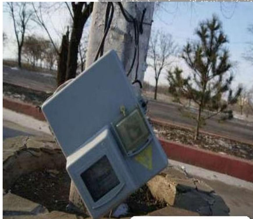
Высота от пола до клеммной крышки счетчика расчетного учета электроэнергии должна быть в пределах **1,3-1,7 м.**
