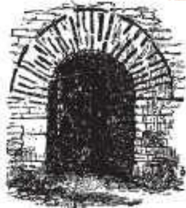
Арка такого типа не была простой копией римского образца, а явилась ее новой видоизмененной модификацией. Принцип радиальной арки не был полностью понят до того, как в Англии началось нормандское строительство.
