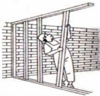
Рис. 4 - Монтаж стоечных профилей
