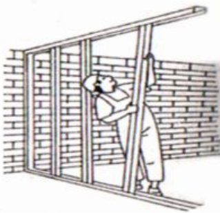
Рис. 4 - Монтаж стоечных профилей
