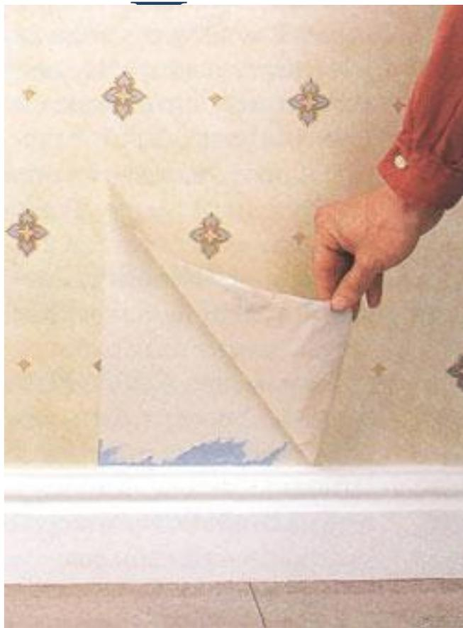
Соскребите отстающие обои скребком или шпателем., предварительно намочив их теплой водой.
