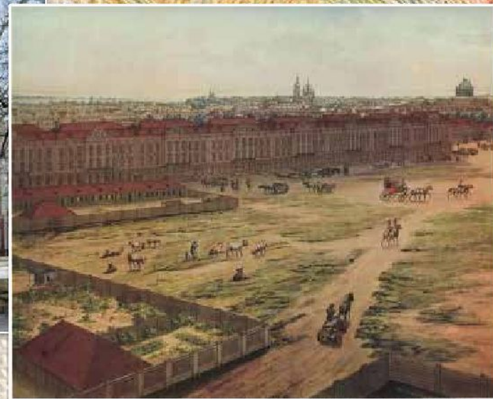
Доменико Трезини Здание Двенадцати коллегий на Васильевском острове, 1722 – 1734
