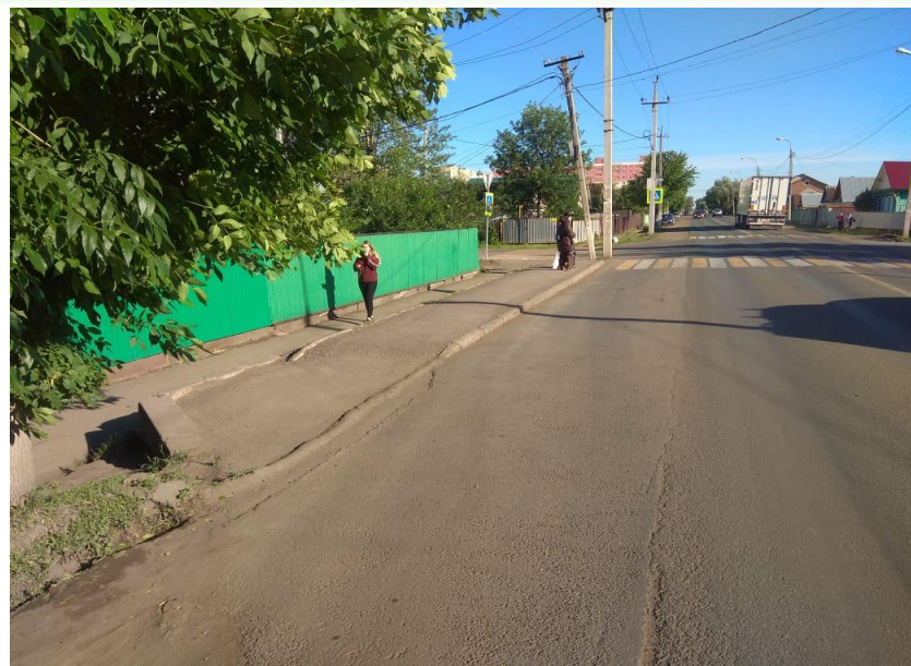
ООТ ул. Аургазинская (отсутствует урна)
