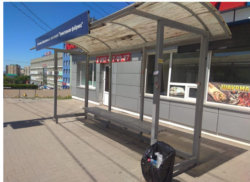
ООТ Трикотажная фабрика (переполненная урна)
