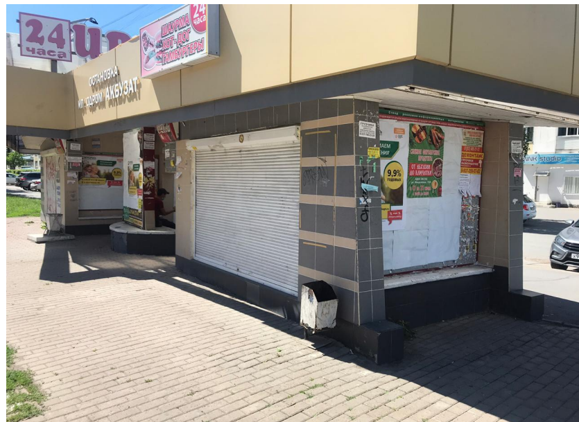
ООТ Ипподром Акбузат (неудовлетворительное состояние урны)
