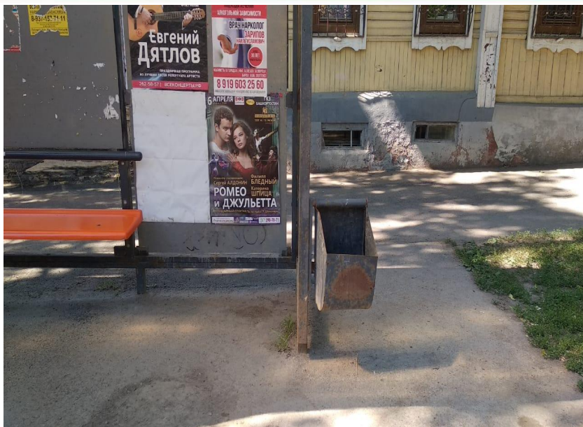
ООТ Октябрьской Революции (неудовлетворительное состояние урны)
