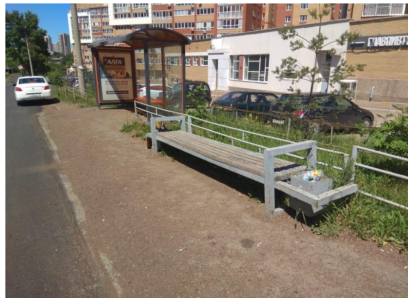
ООТ Красногвардейская (переполненные урны)
