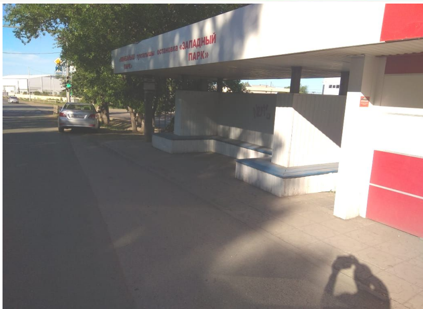
ООТ Западный Парк (отсутствует урна)
