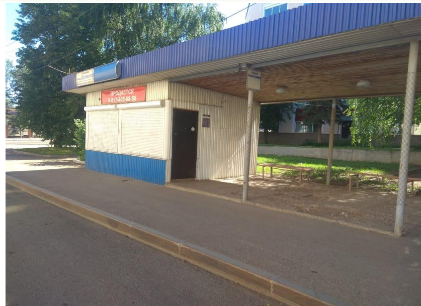
ООТ Достоевского (отсутствует урна)
