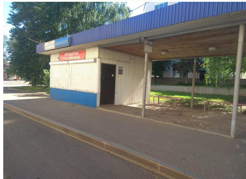
ООТ Достоевского (отсутствует урна)
