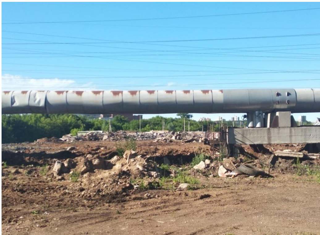
Навал мусора по ул. С. Богородская
