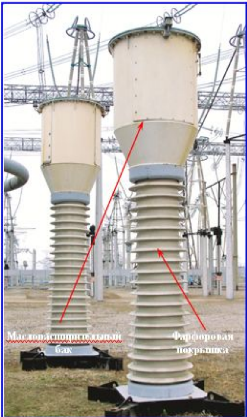
Трансформатор ТФРМ-750 (нижний каскад)
