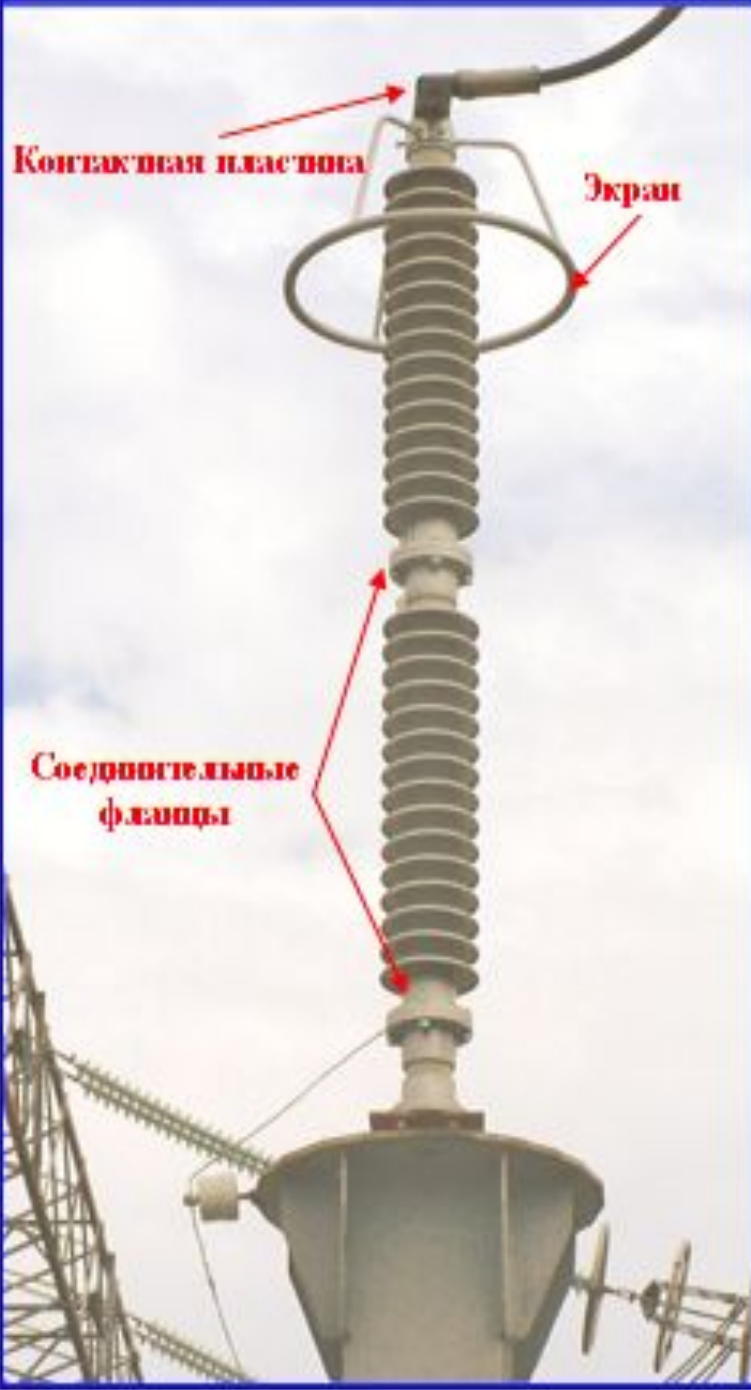
Ограничитель грозовых и коммутационных перенапряжений нелинейный ОПН – 150 УХЛ1 (с полимерной изоляцией)
