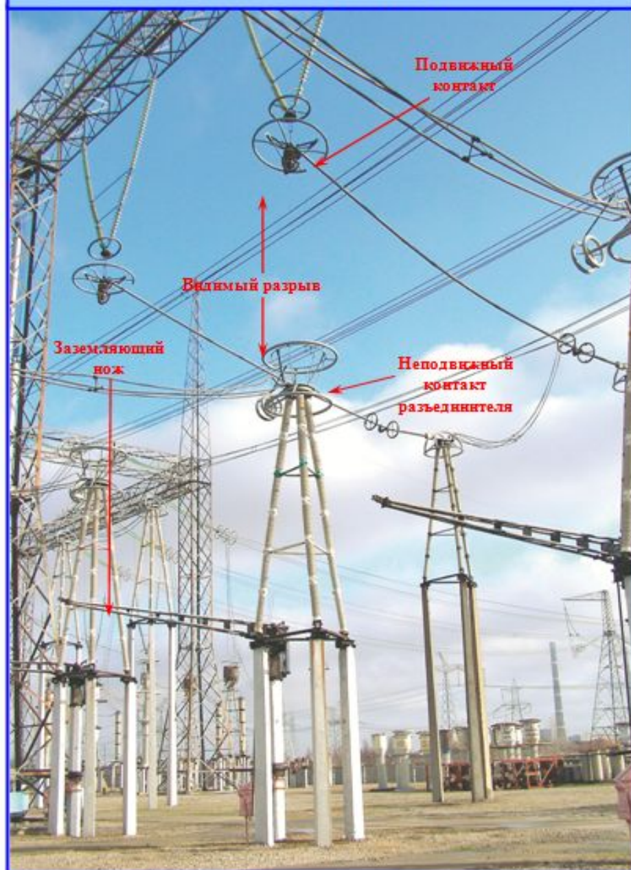
Разъединитель РПД – 750/3150-У1 (Отключенное положение)
