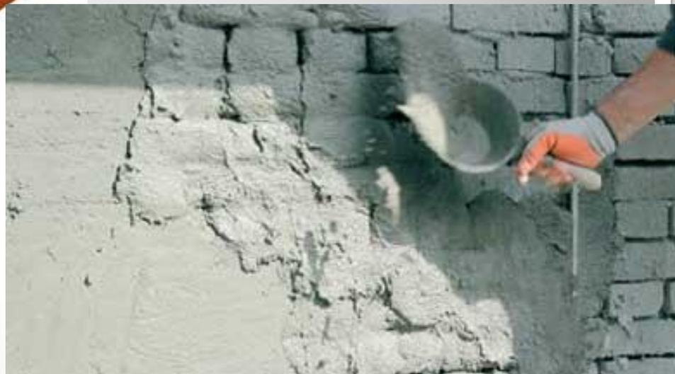
**Ковш – для набрасывания раствора при оштукатуривании, дозирования материалов при приготовлении раствора**
