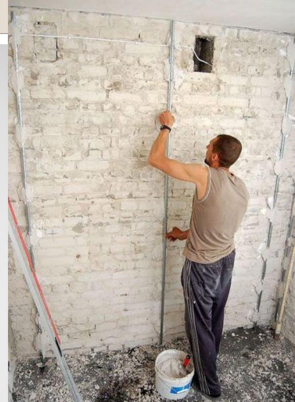
Маяки. Выступают в качестве направляющих для создания идеально ровной плоскости при оштукатуривании
