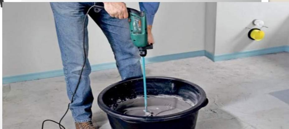
**Строительный миксер - для замешивания небольших объемов раствора механическим способом.**
