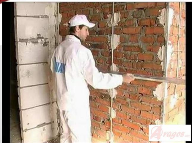
**Уровень – для контроля ровности поверхности, для провешивания и установки маяков**
