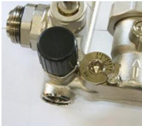
При помощи этого клапана задаётся соотношение расходов теплоносителей первичного и вторичного контуров, то есть задаётся температура теплоносителя в подающем трубопроводе вторичного контура. Поворот клапана осуществляется шестигранным ключом, для предотвращения случайного поворота во время эксплуатации клапан фиксируется зажимным винтом. На клапане имеется шкала со значениями пропускной способности клапана от 0 до 5 м<sup>3</sup> час.
