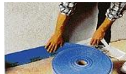
Практика показывает, что к-во ДЛ в метрах, соответствует общей площади всех помещений + деформационный шов если он есть.
