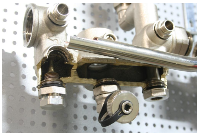
Балансировочно-запорный клапан первичного контура
