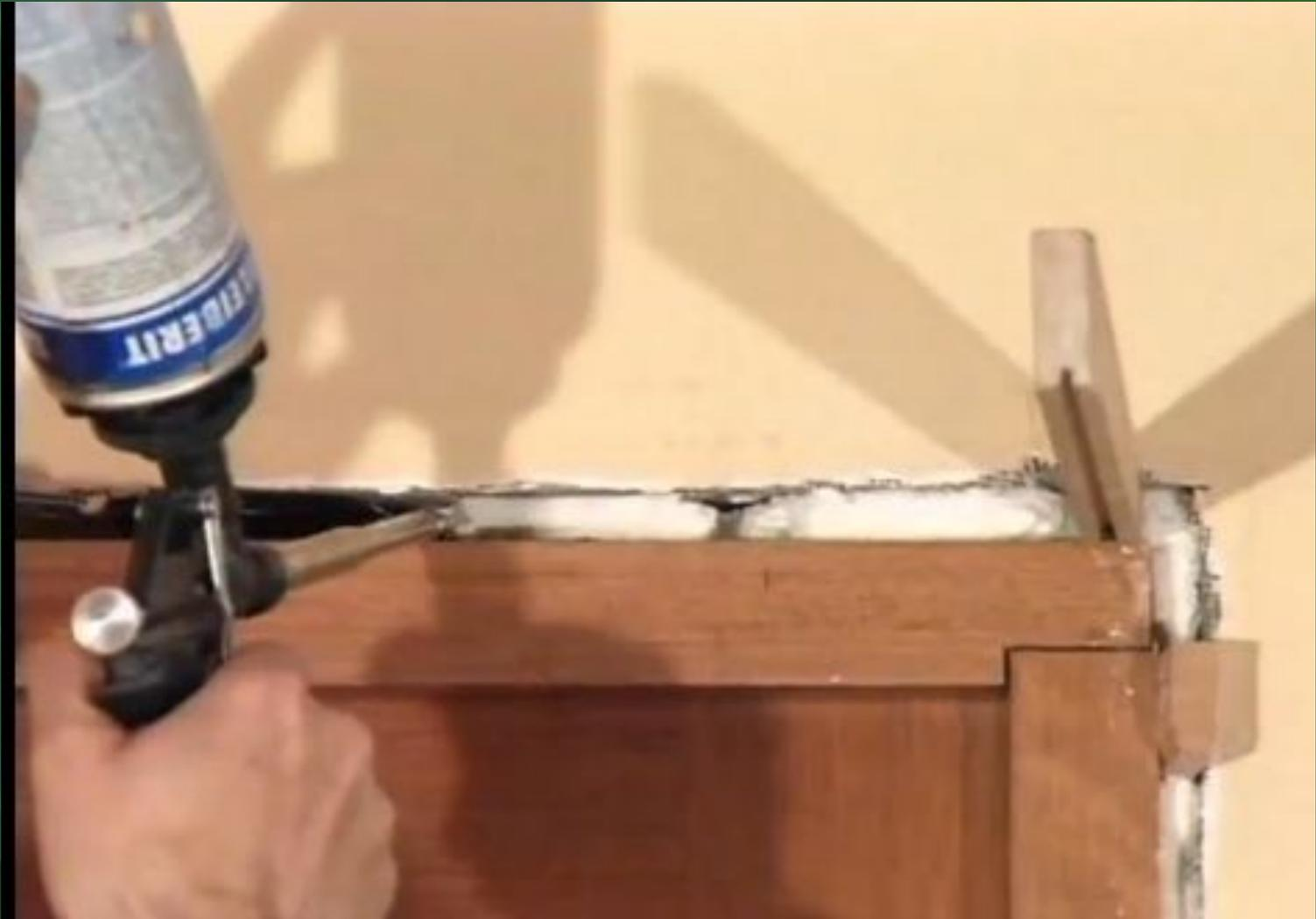
Двери в коробках устанавливают с зазорами 1,5-2 мм, с учётом их уменьшения при последующих окрасках. Внутри помещения зазор между дверью и полом должен быть в пределах 10-20
