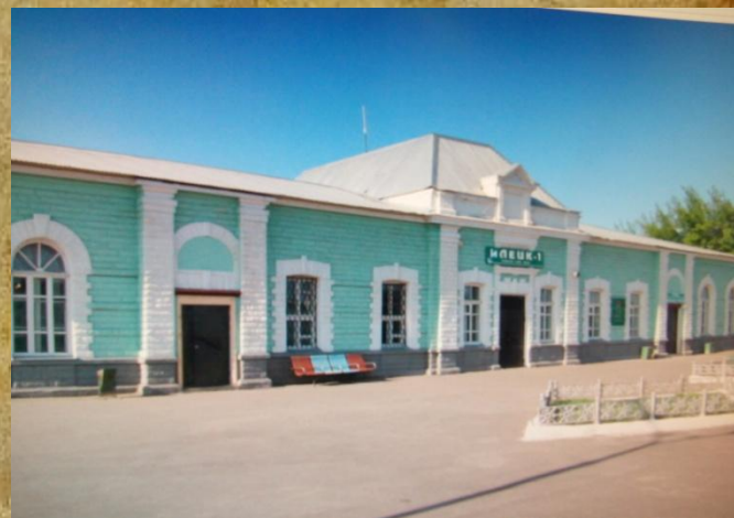
Станция Илецк в наше время
