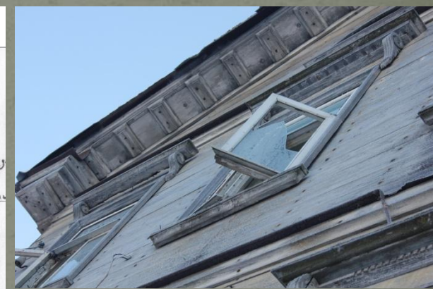
6. Северо-западный фасад. Элементы декоративного убранства
