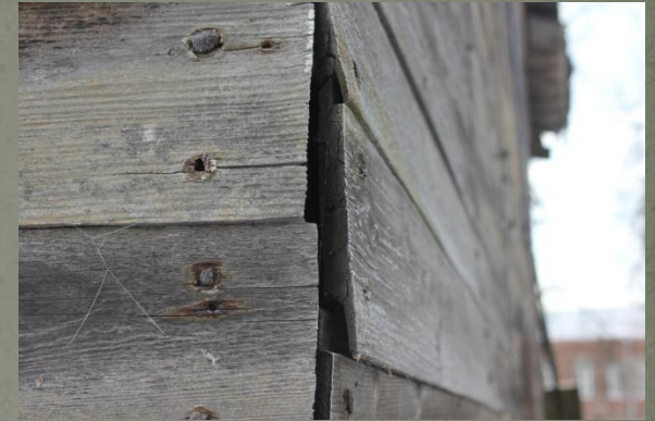
Профили досок в обшивке фасада
