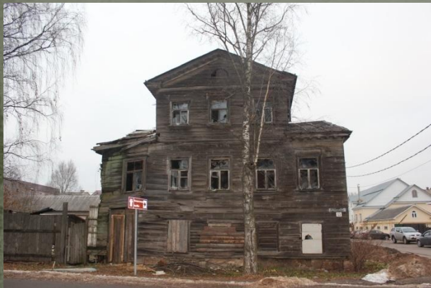
3. Юго-западный фасад. Вид с Ю-З. Фото 2016 г.
