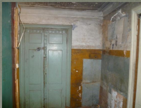
Лестничная клетка и двери в жилые комнаты
