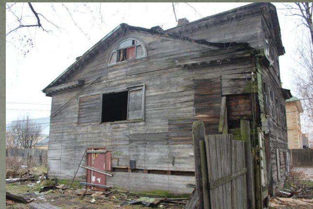
5. Северо-западный фасад. Вид с С-З. Фото 2016 г.
