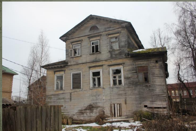
4. Северо-восточный фасад. Вид с С-В. Фото 2016 г.
