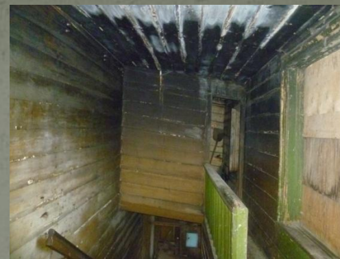
Сени. Южное помещение 2-го этажа
