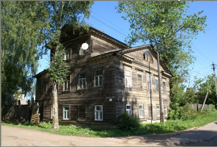
1. Общий вид с юга. Фото 2006 г.
