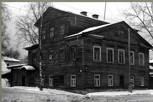
Ю-З и Ю-В фасады. Фото 1977 г.
