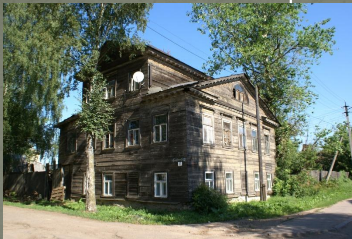
1. Общий вид с юга. Фото 2006 г.
