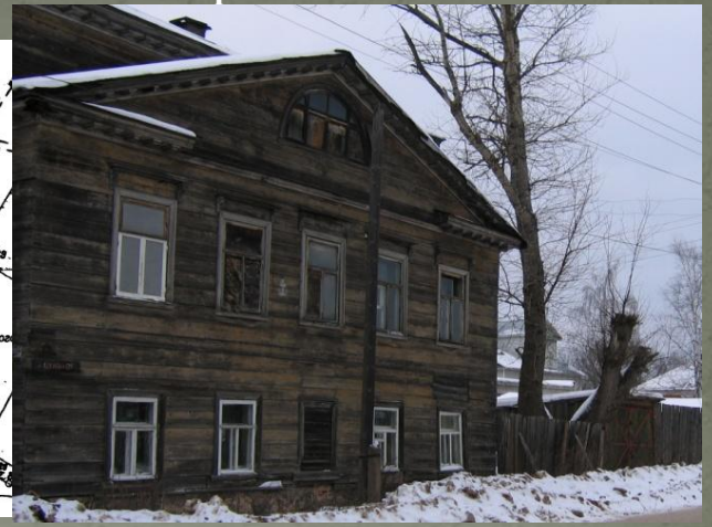
2. Юго-восточный фасад. Вид с Ю-В. Фото 2006 г.
