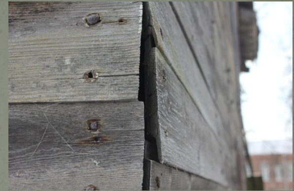
Профили досок в обшивке фасада
