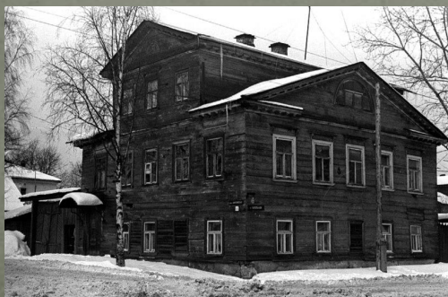
Ю-З и Ю-В фасады. Фото 1977 г.
