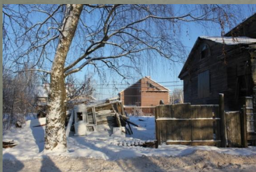
Общий вид с Ю-З на участок флигеля
