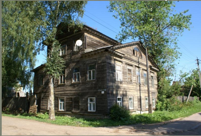
1. Общий вид с юга. Фото 2006 г.
