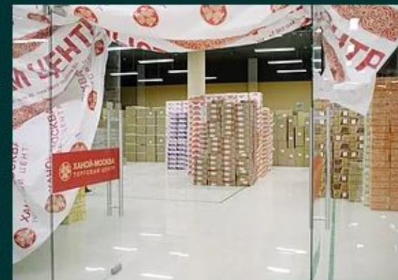
Подготовка нашего помещения
