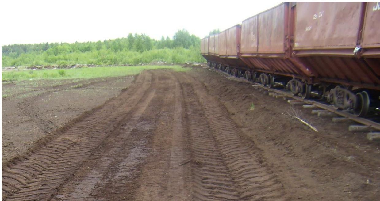
Рисунок 4.6 – Железнодорожный состав на временных путях, проложенных на разрабатываемом торфяном месторождении
