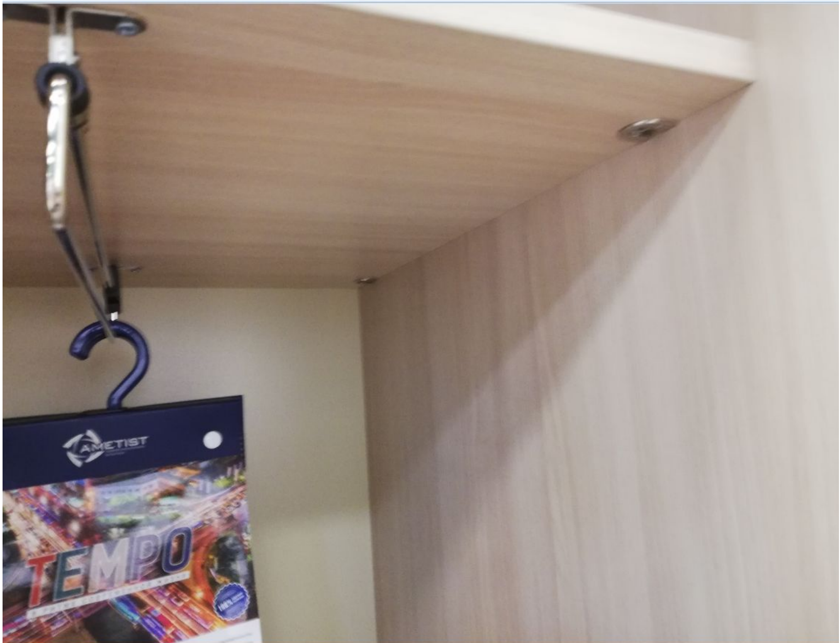
Эксцентриковая стяжка VB 35 М
