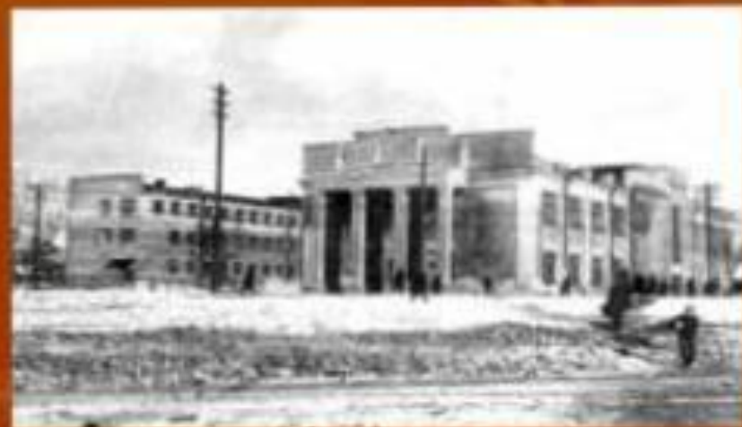
Фабрика-кухня ГВРЗ им. Рудзутака. Омск. 1942
