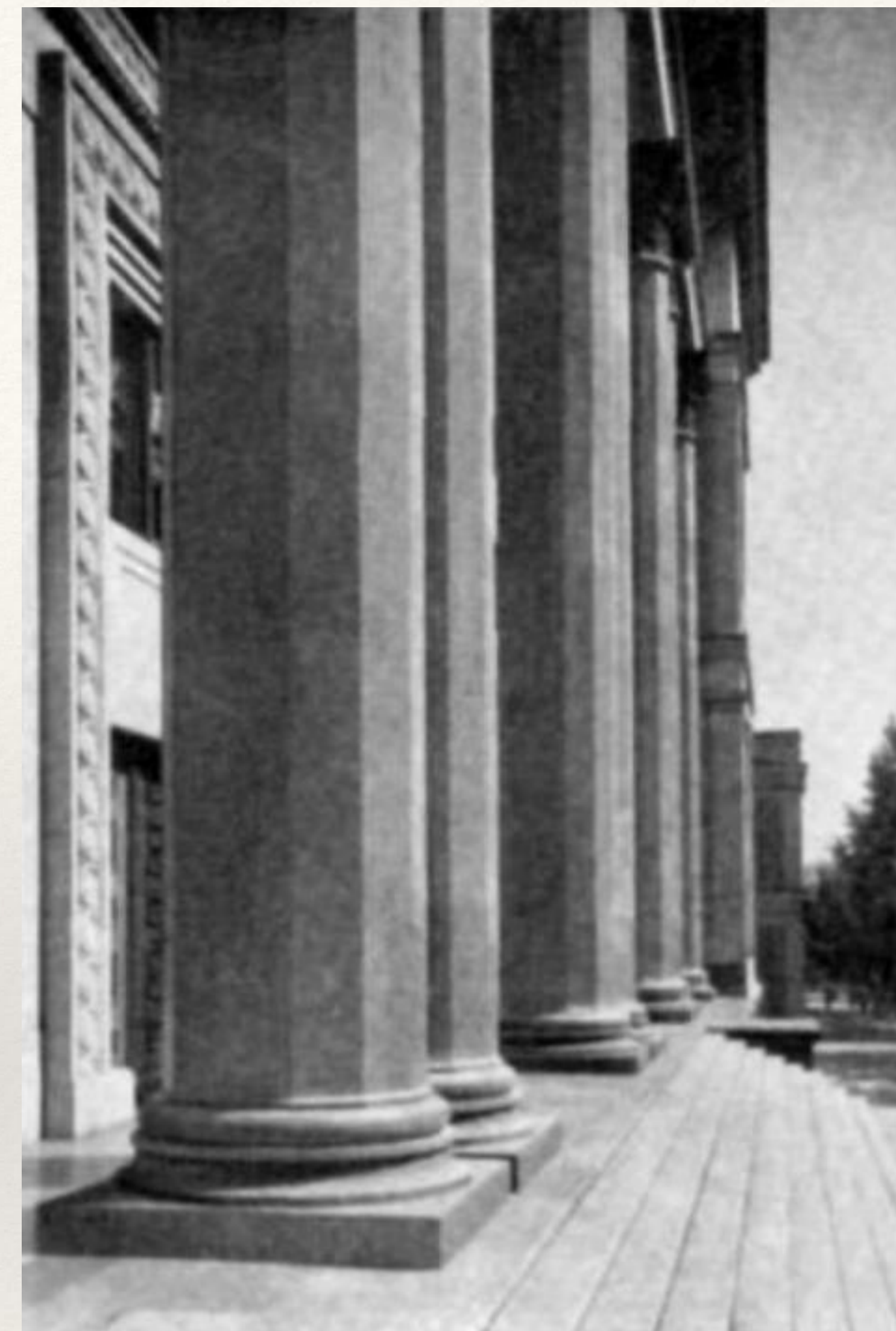
Колонны портика главного фасада.
