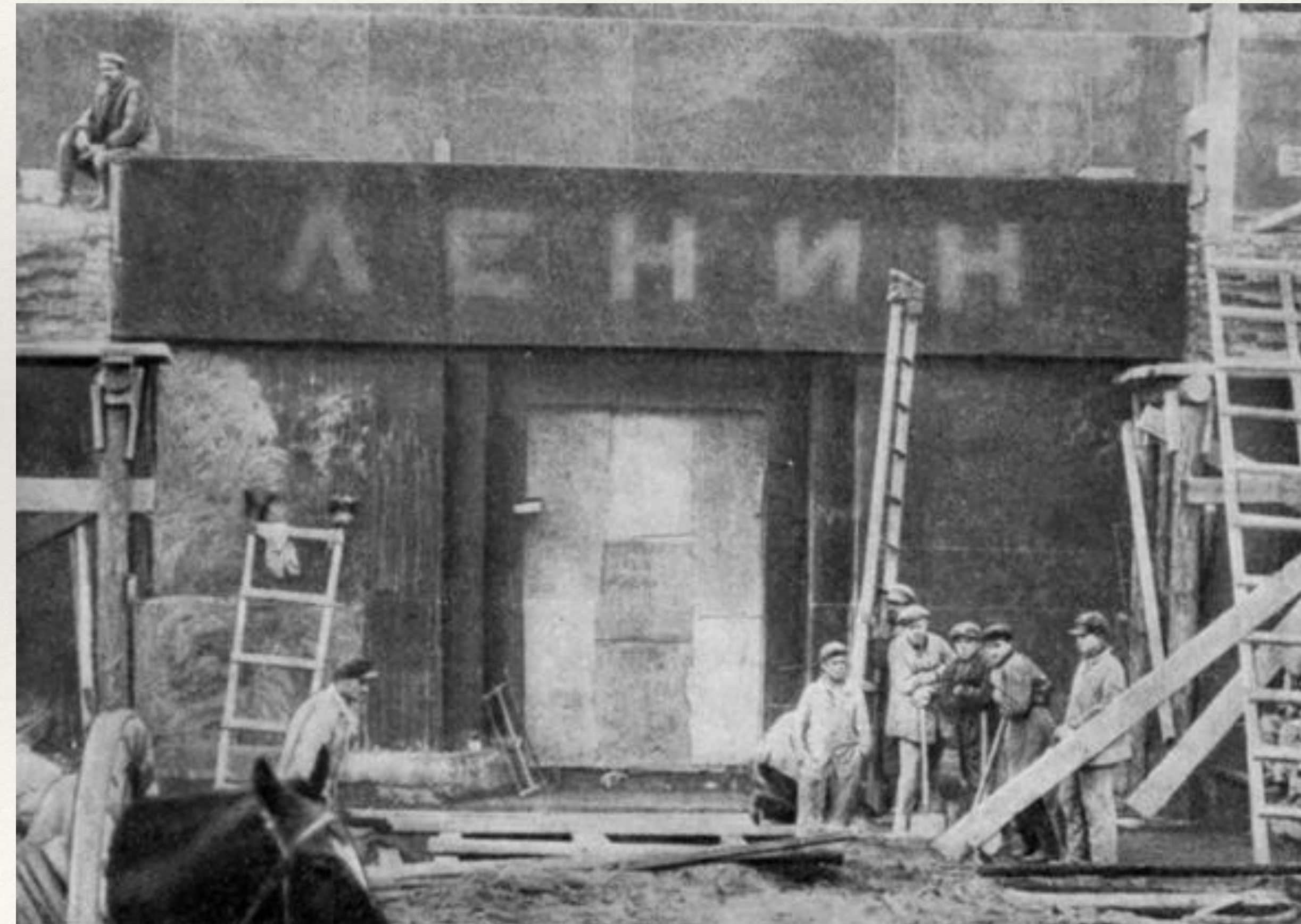
Установка большого монолита-аттика над главным порталом.
