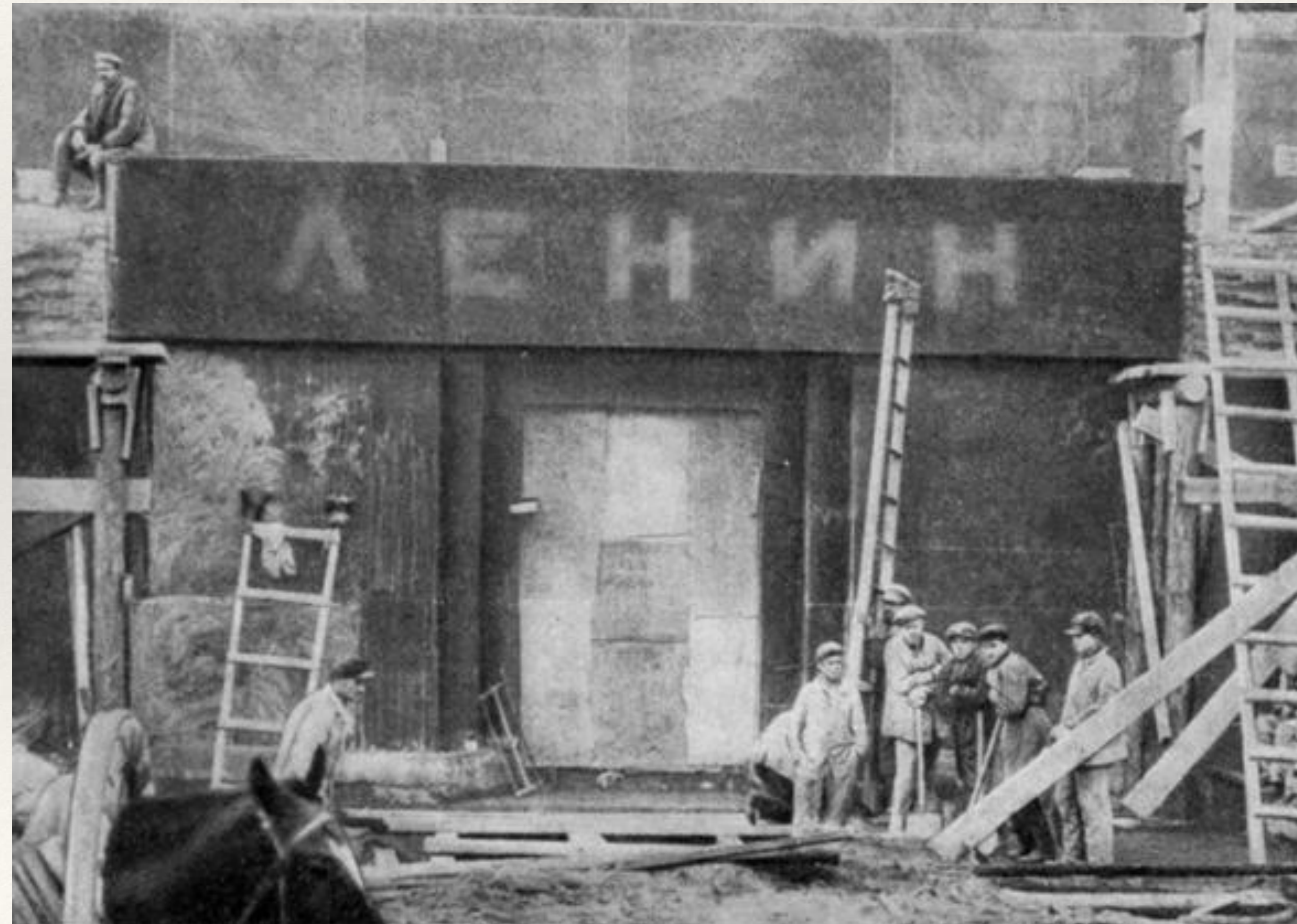
Установка большого монолита-аттика над главным порталом.
