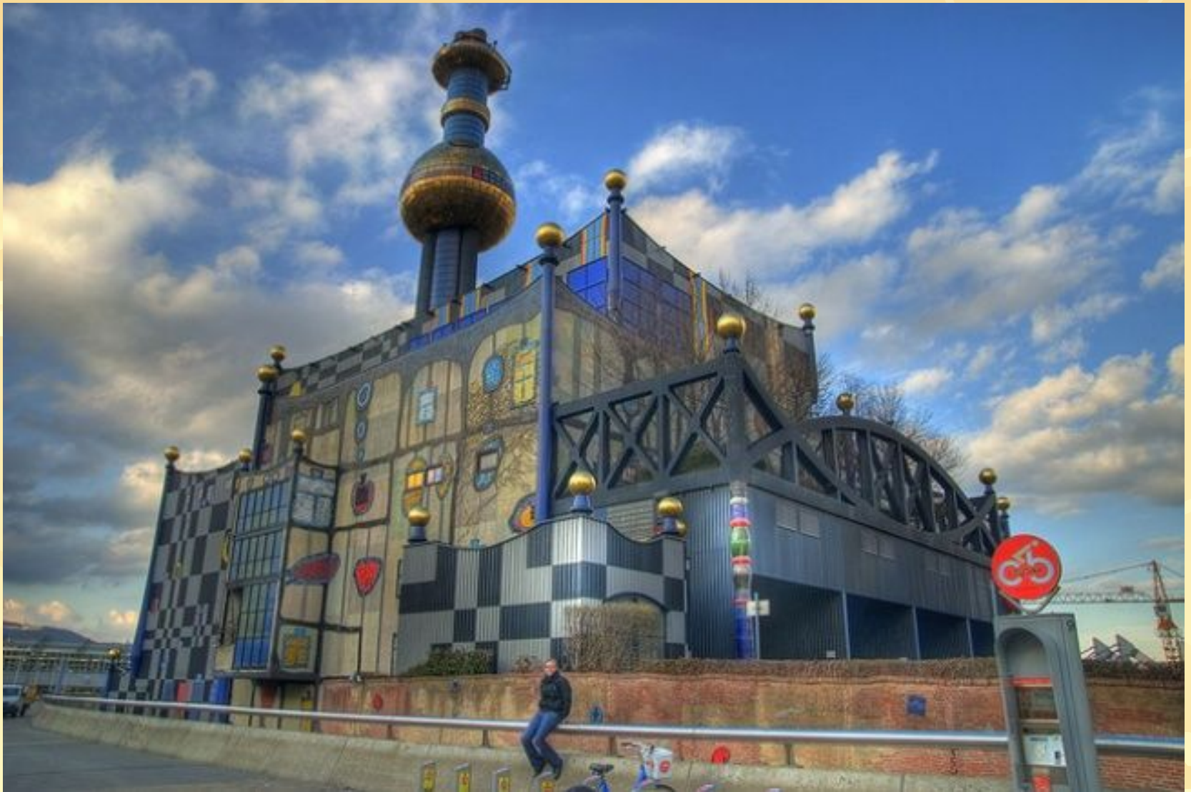
Мусоросжигательный завод Шпиттелау Вена, Австрия
