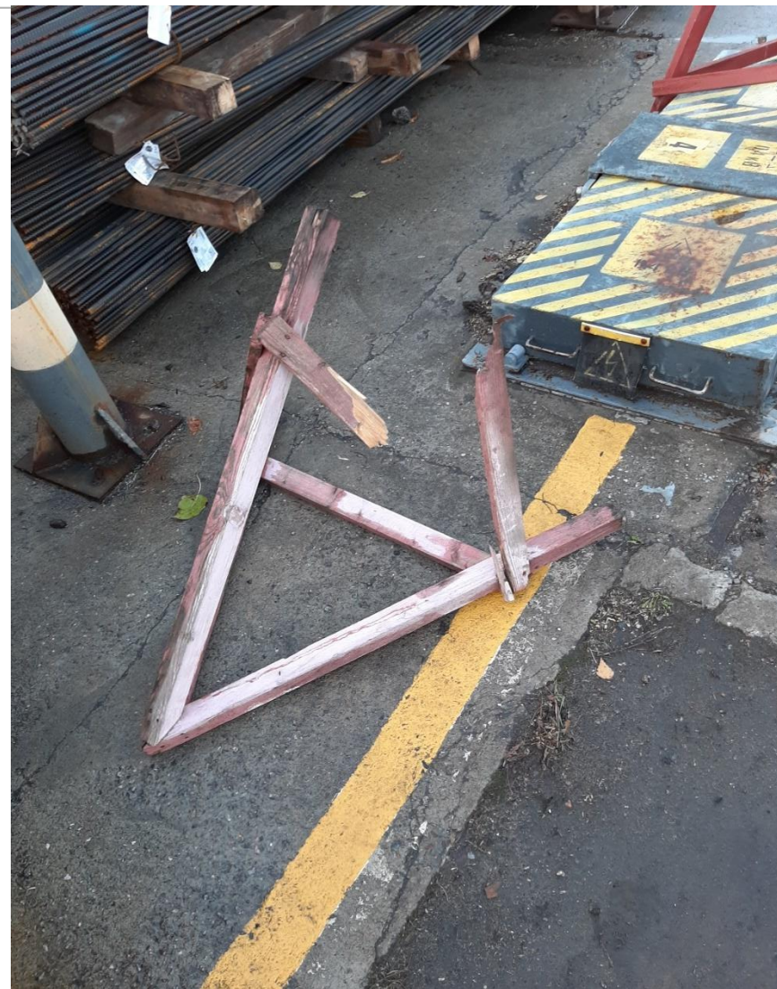
Повреждение ограждения электроколонок.
