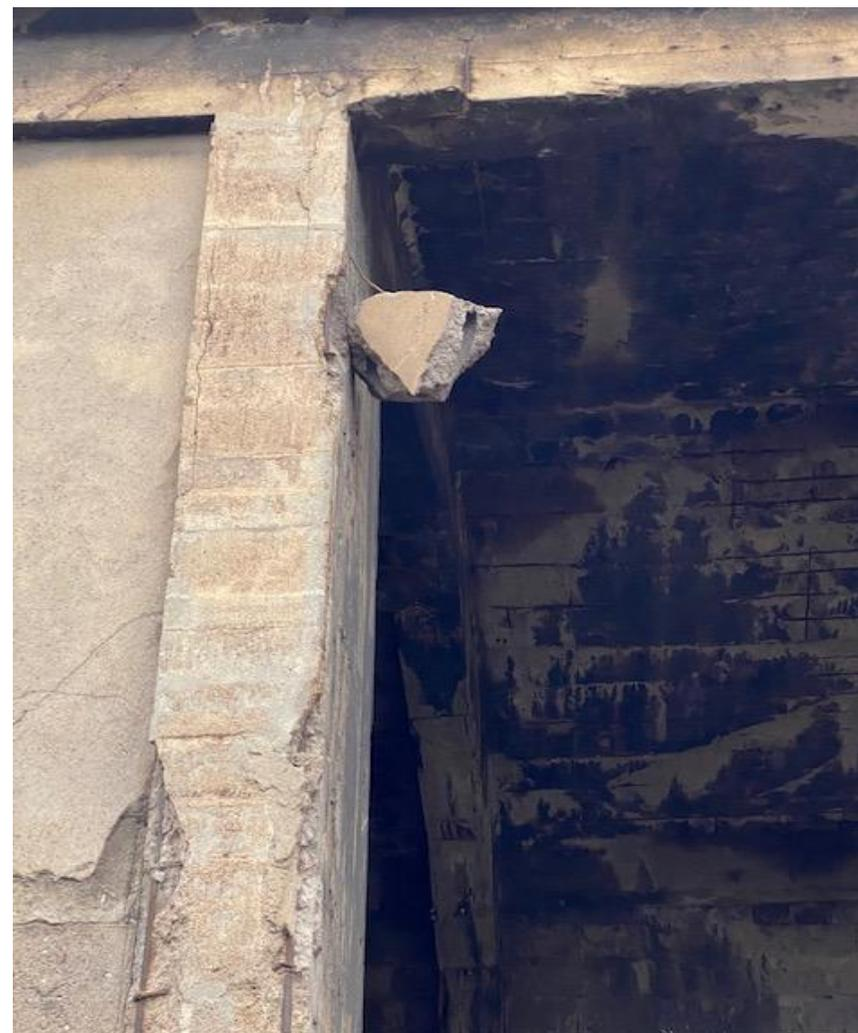
**При въезде в склад на арматуре висит кусок бетона.**
