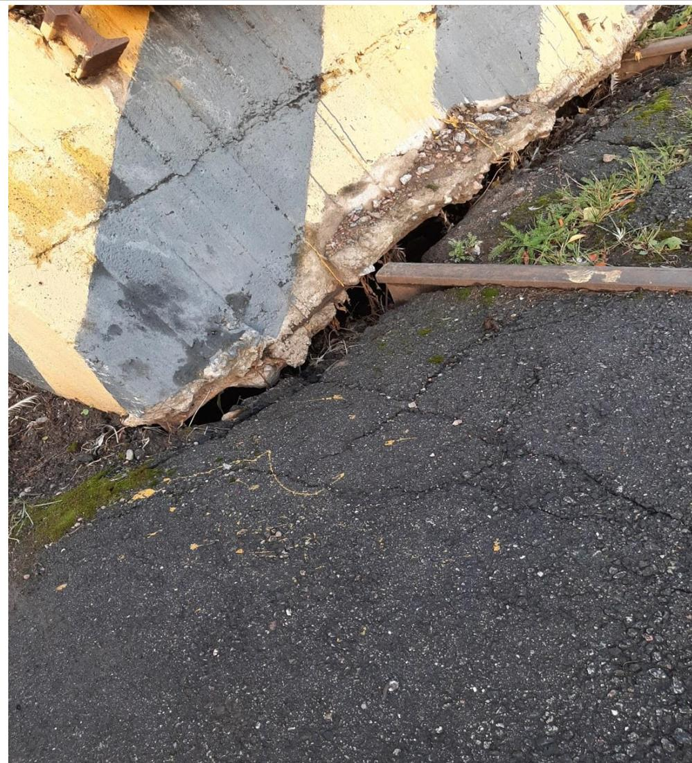
**Провал грунта под железобетонным тупиком,
