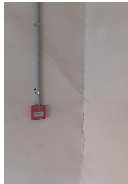
**Трещины в несущих конструкциях (стены, потолок).**
