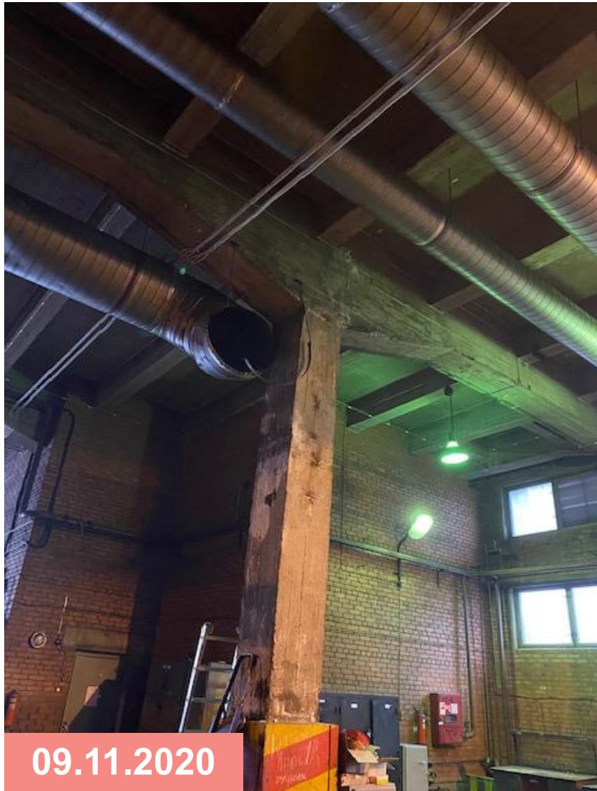
Повреждение вентиляционного короба.
