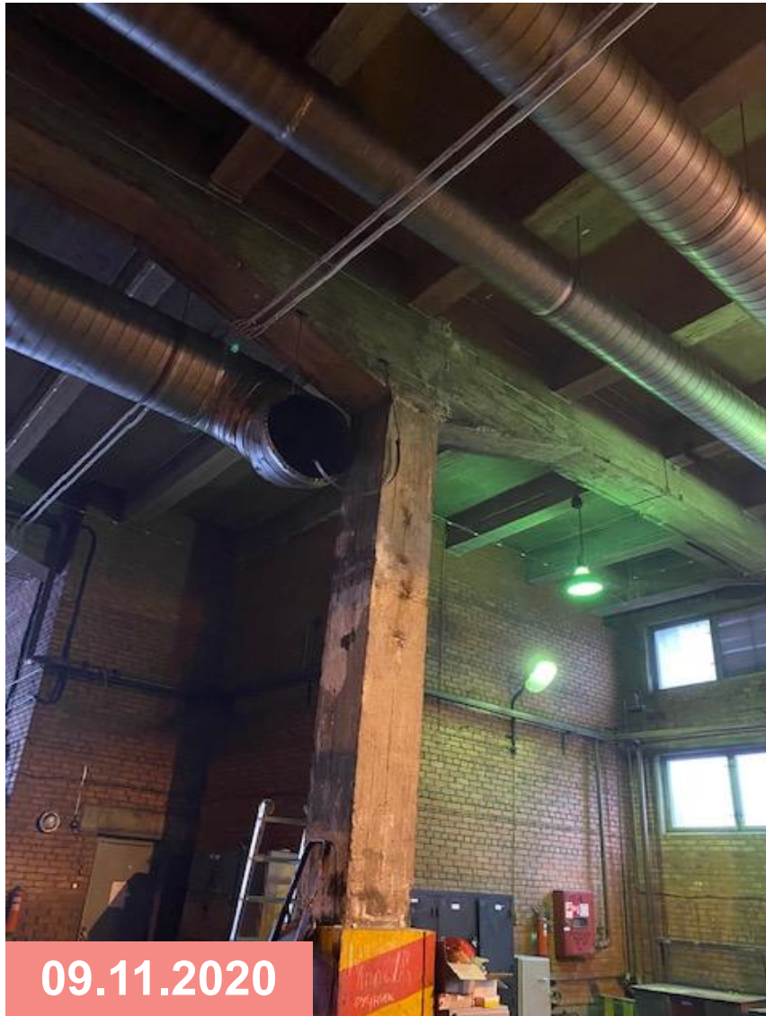
Повреждение вентиляционного короба.
