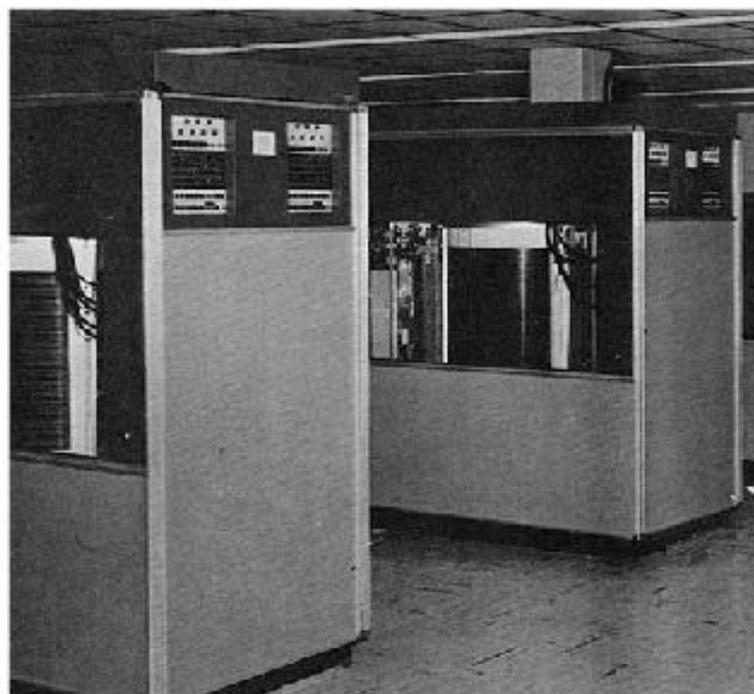
Два жёстких диска (disk files) машины IBM 305
