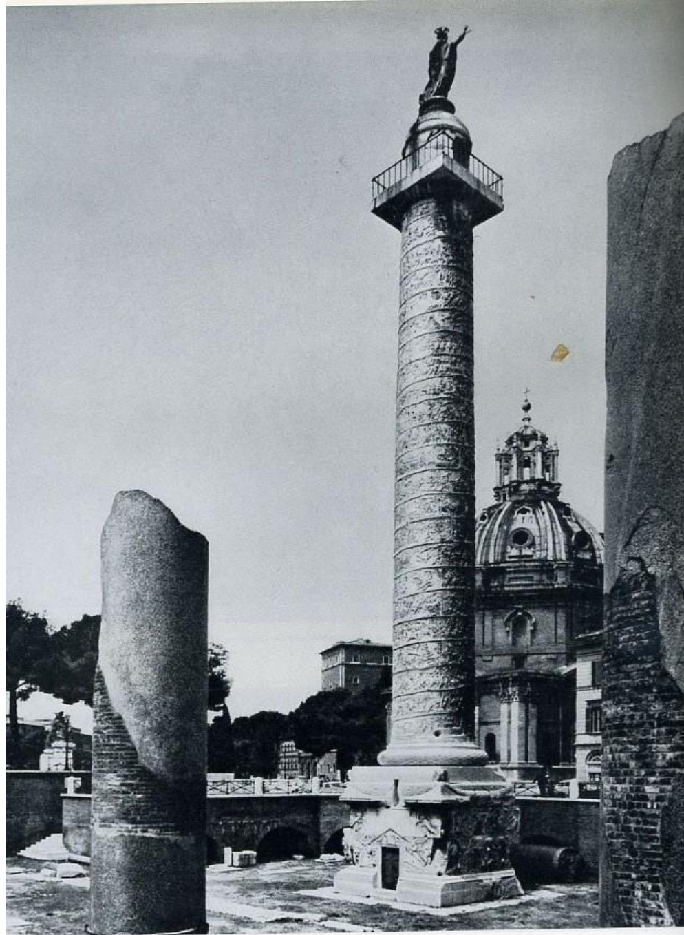
204. Колонна Траяна на форуме Траяна в Риме, 107—113 гг. Архитектор Аполлодор из Дамаска
