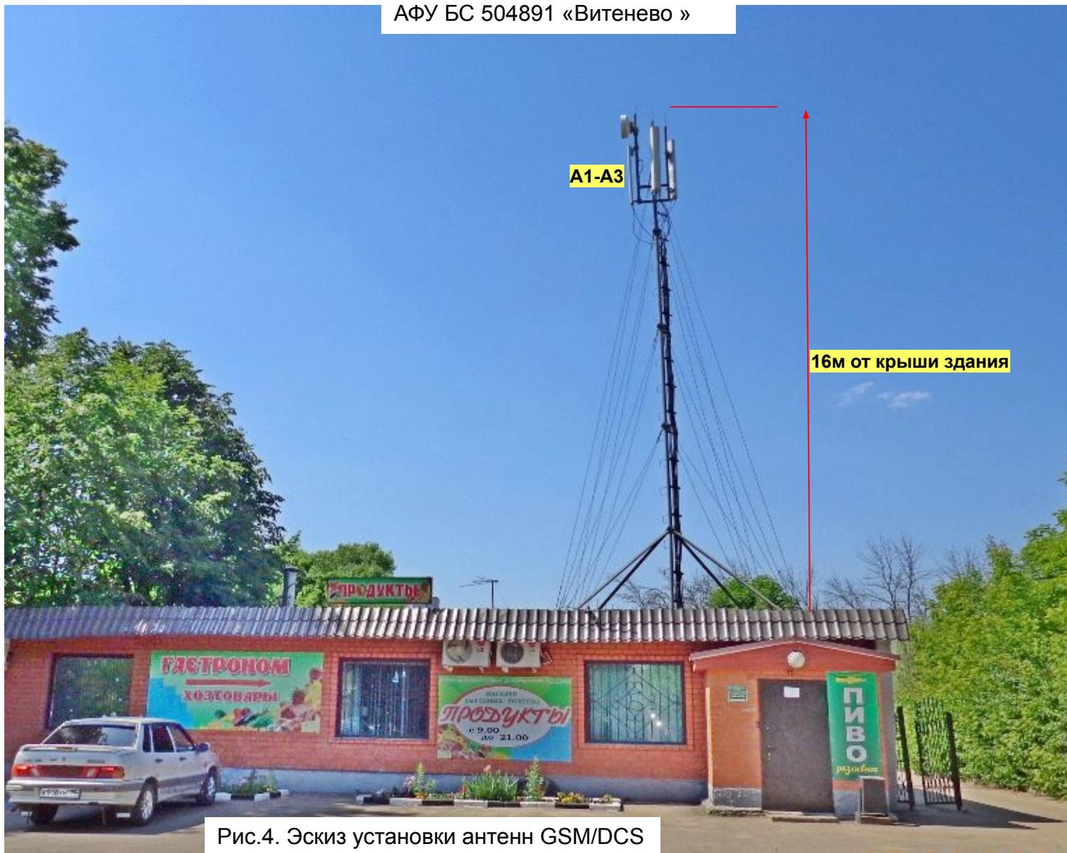
Рис.4. Эскиз установки антенн GSM/DCS
