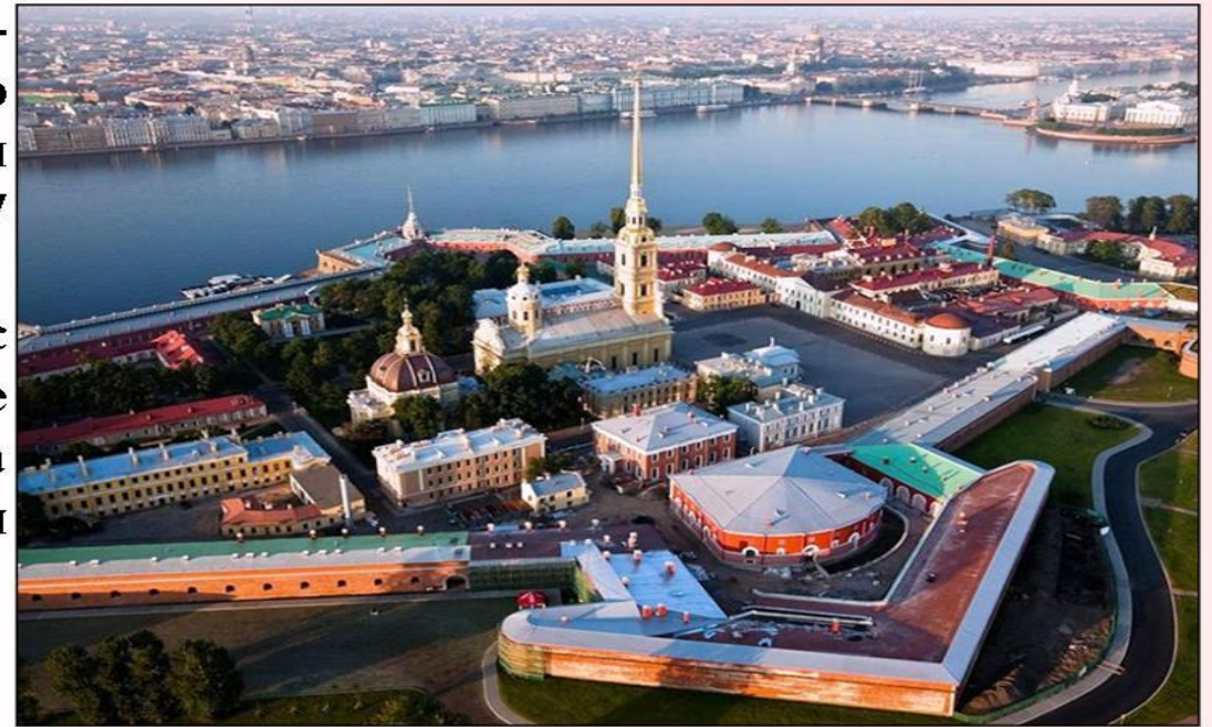
Петропавловская крепость - сердце Санкт-Петербурга... Именно с неё и начался строиться город на Неве
