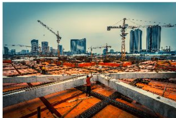
Охрана строительных объектов
