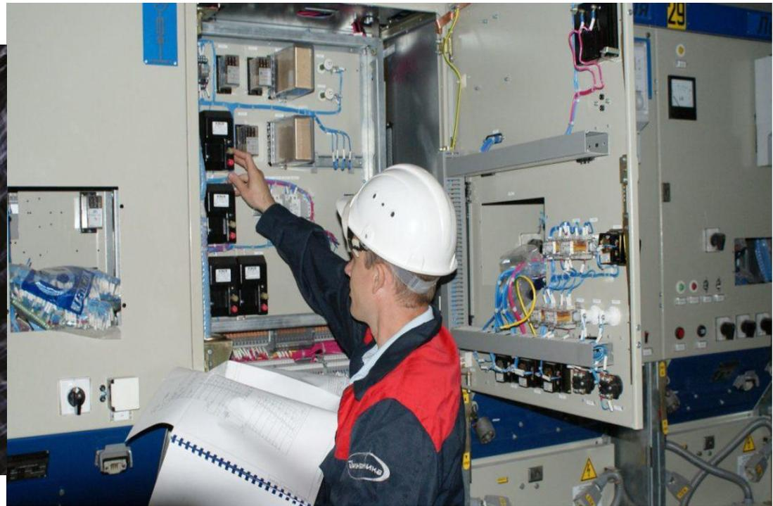
**При текущем ремонте проверяют состояния болтовых креплений и контактных соединений тележки и корпуса, контактных соединений проводников вторичной коммутации; регулируют разъединяющие контакты первичных и вторичных цепей; проверяют и регулируют механизмы блокировки, фиксации, взаимодействие привода и выключателя.**
