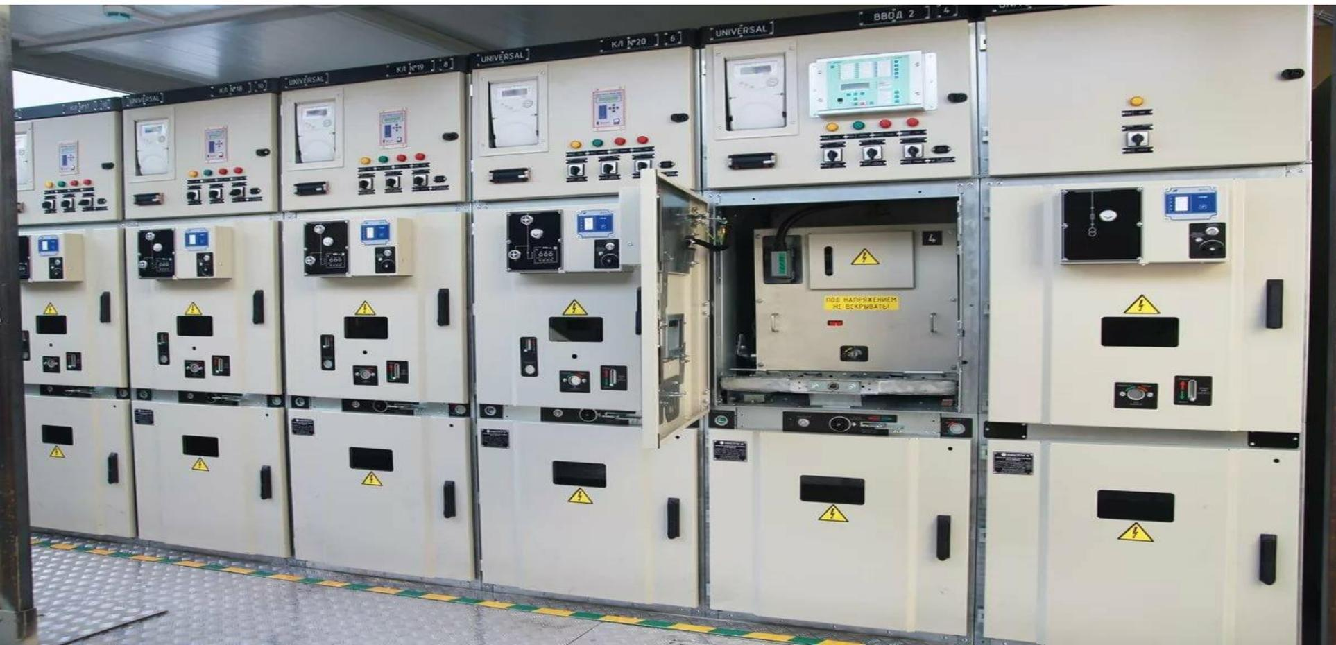
**Распределительные устройства (РУ) предназначены для приема и распределения электричества одного напряжения, а также для питания оборудования в пределах электроустановки.**
