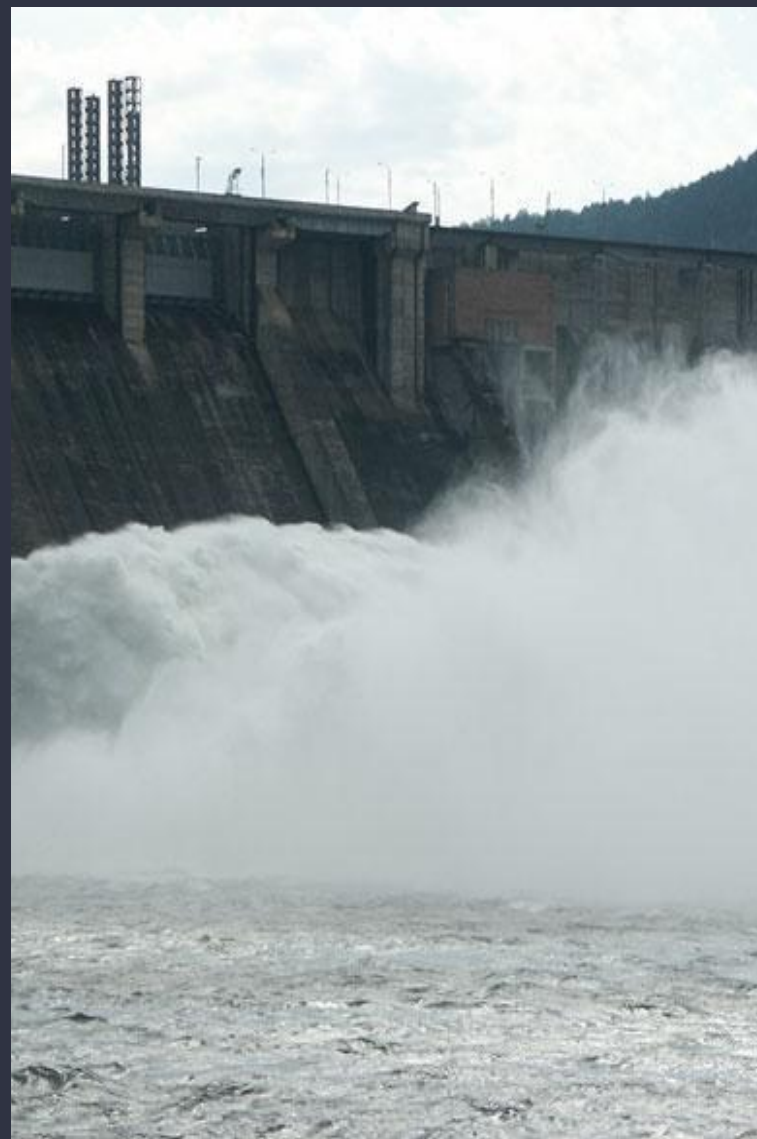
Водосброс Красноярской ГЭС
