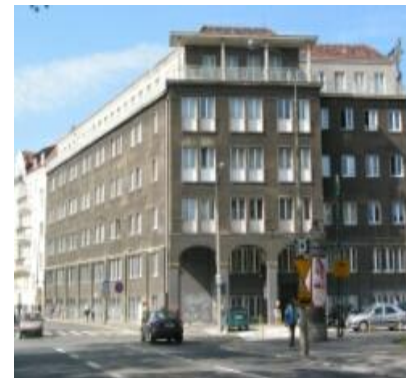
Budynek C ul. Towarowa 53
