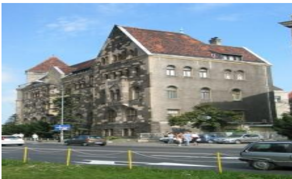
Budynek B al. Niepodległości 12
