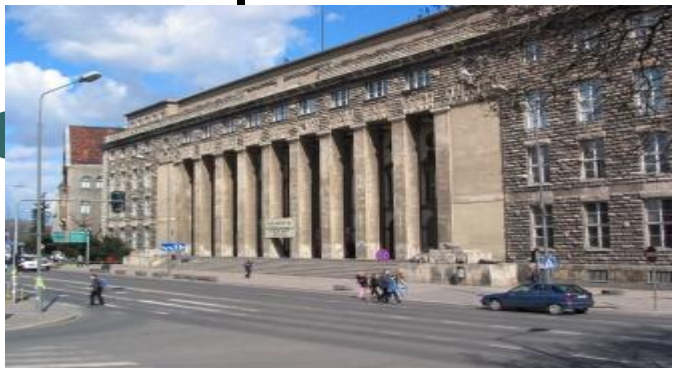
Budynek A al. Niepodległości 10
