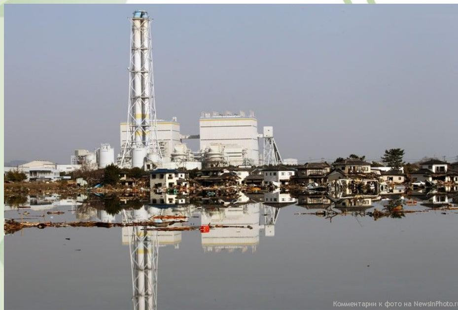
Вслед за подземными толчками магнитудой 9,0 на побережье пришла 14-метровая волна цунами, которая затопила четыре из шести реакторов АЭС и вывела из строя систему охлаждения реакторов, что привело к серии взрывов водорода, расплавлению активной зоны.
