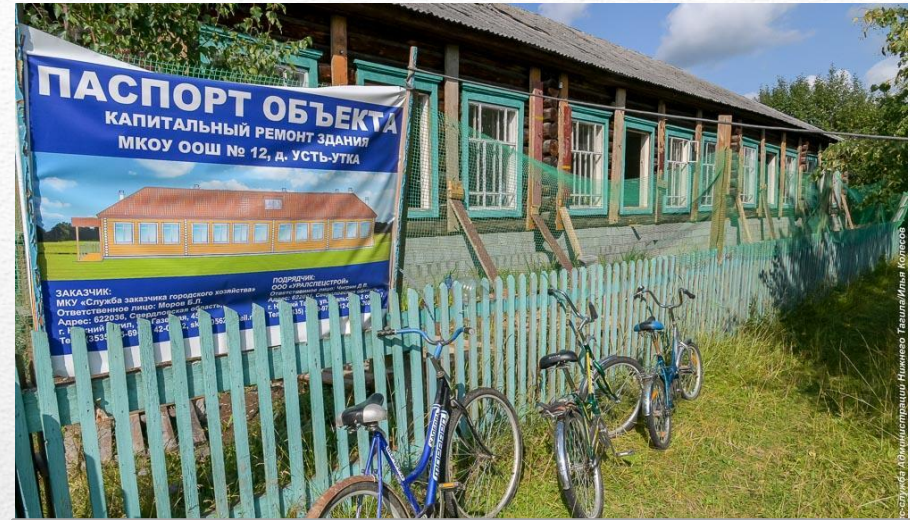
Капитальный ремонт школы №12
