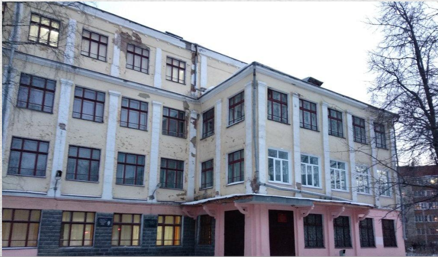
Капитальный ремонт школы №23
