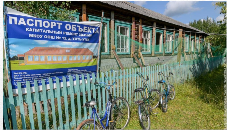
Капитальный ремонт школы №12
