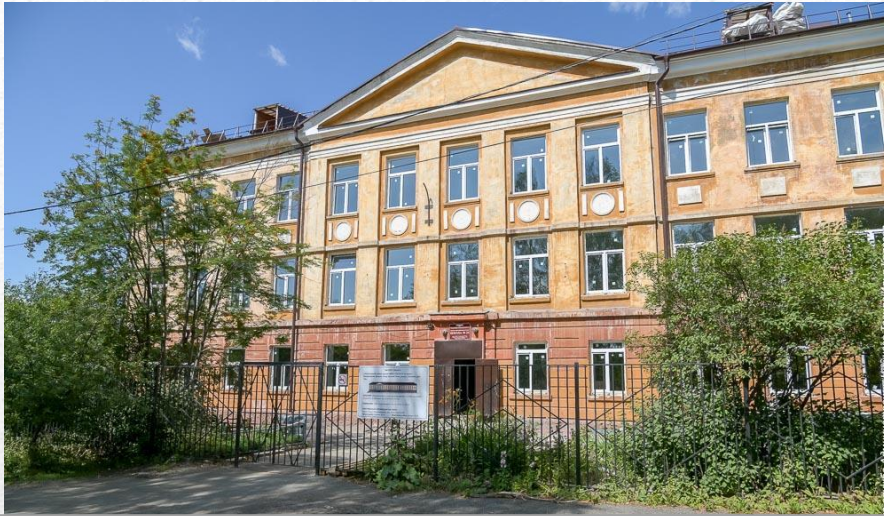
Капитальный ремонт школы №24
