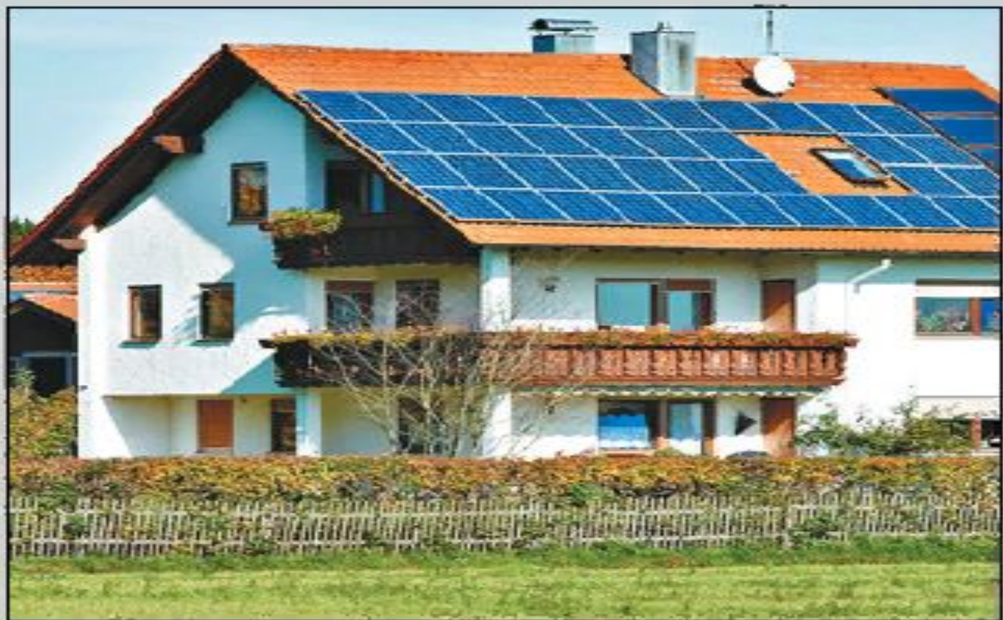
Рис. 5. Дом с солнечными панелями на крыше
