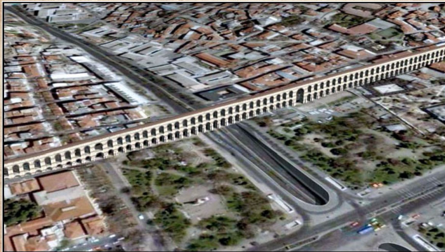
Акведук Валента (реконструкция, Стамбул, 368-375 гг.)
