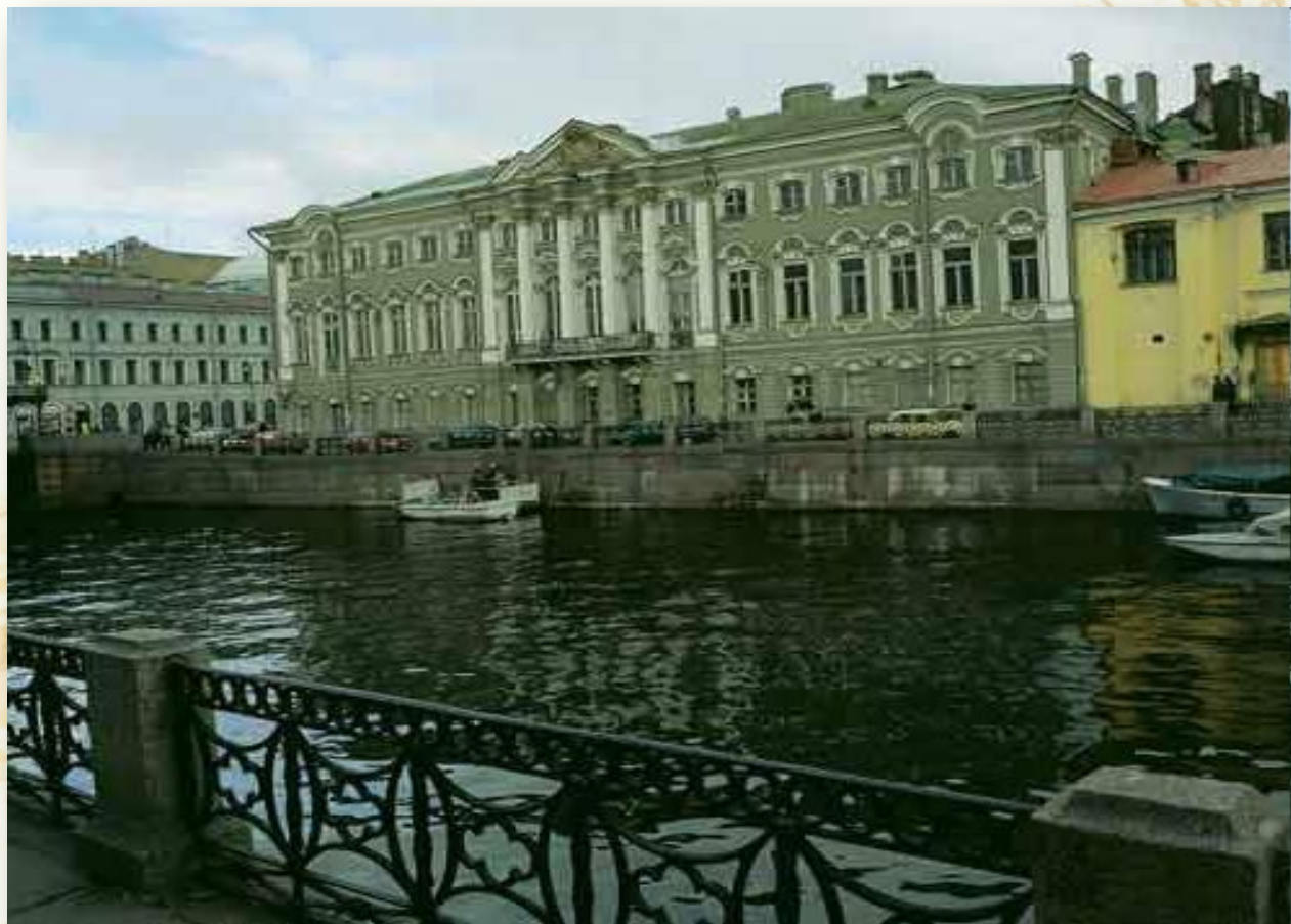
Стогановский дворец. Западный фасад вдоль набережной Мойки
