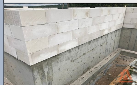
газобетон и цемент
