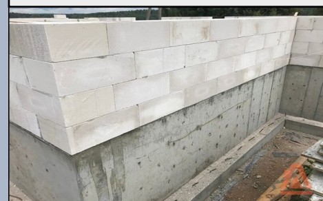
газобетон и цемент
