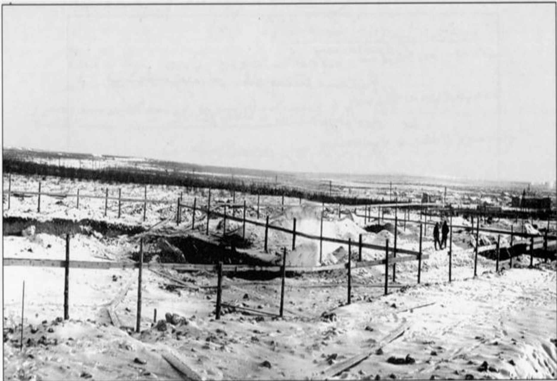
Начало строительства клуба ЧМС.
