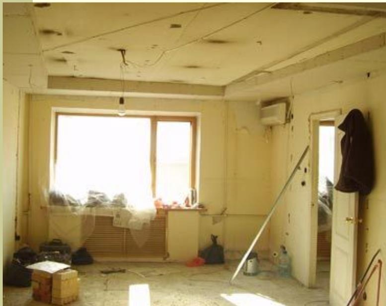
**Перед началом клейки обоев необходимо выполнить подготовительные работы: очистку стен от старого набега, старых обоев, выравнивание гипсовыми, либо клеевыми растворами, шпатлевку и шлифовку стен.**
