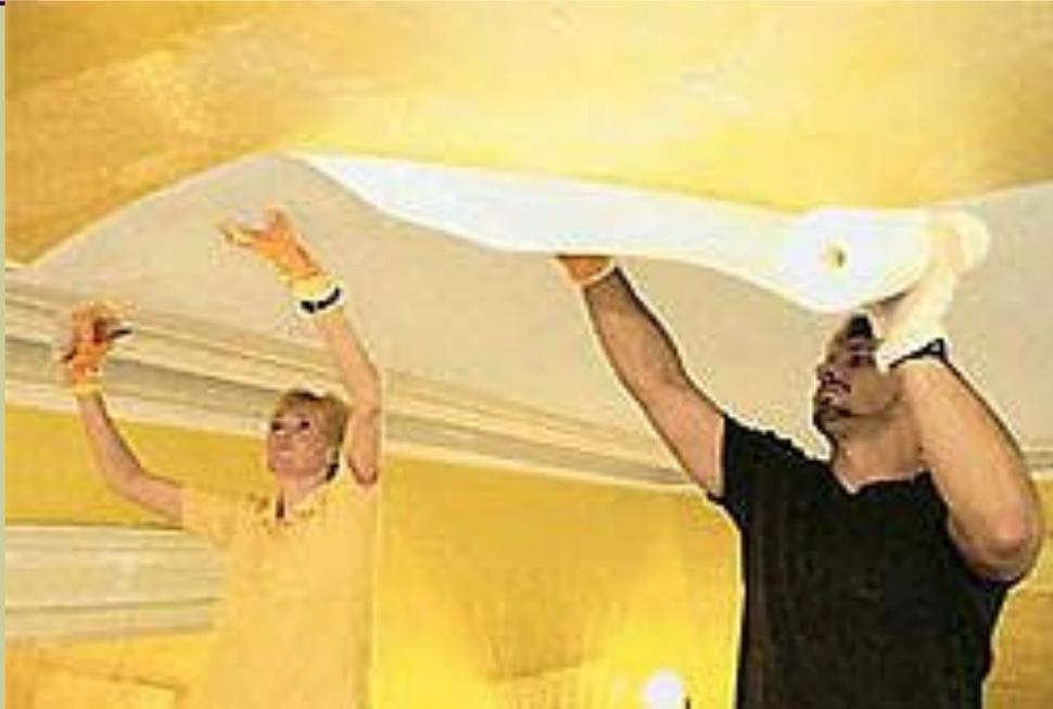
*Оклейку потолков выполняют, стыкуя обои параллельно лучам света из окна, чтобы стыки были менее заметны. Кромки обоев выпускают на стены на 50...60 мм, чтобы закрыть углы между потолком и стенами.*
