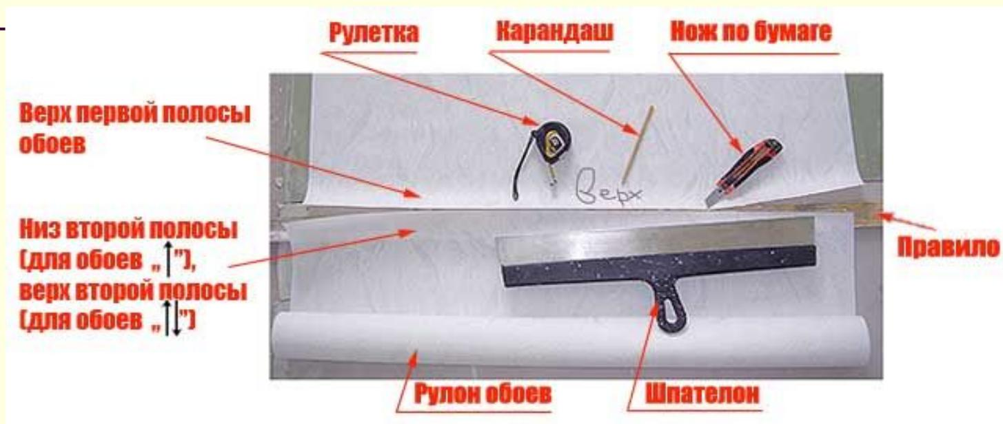
*Нарезку полос и смачивание обоев клеем выполнять на полу, при этом пол необходимо застелить полиэтиленовой пленкой или старыми ненужными обоями. Длина первой полосы обоев равна высоте помещения плюс 3-5 см (длина обоев в рулоне кратна 2,5 м). Нарезку обоев производить ножом по бумаге.*
