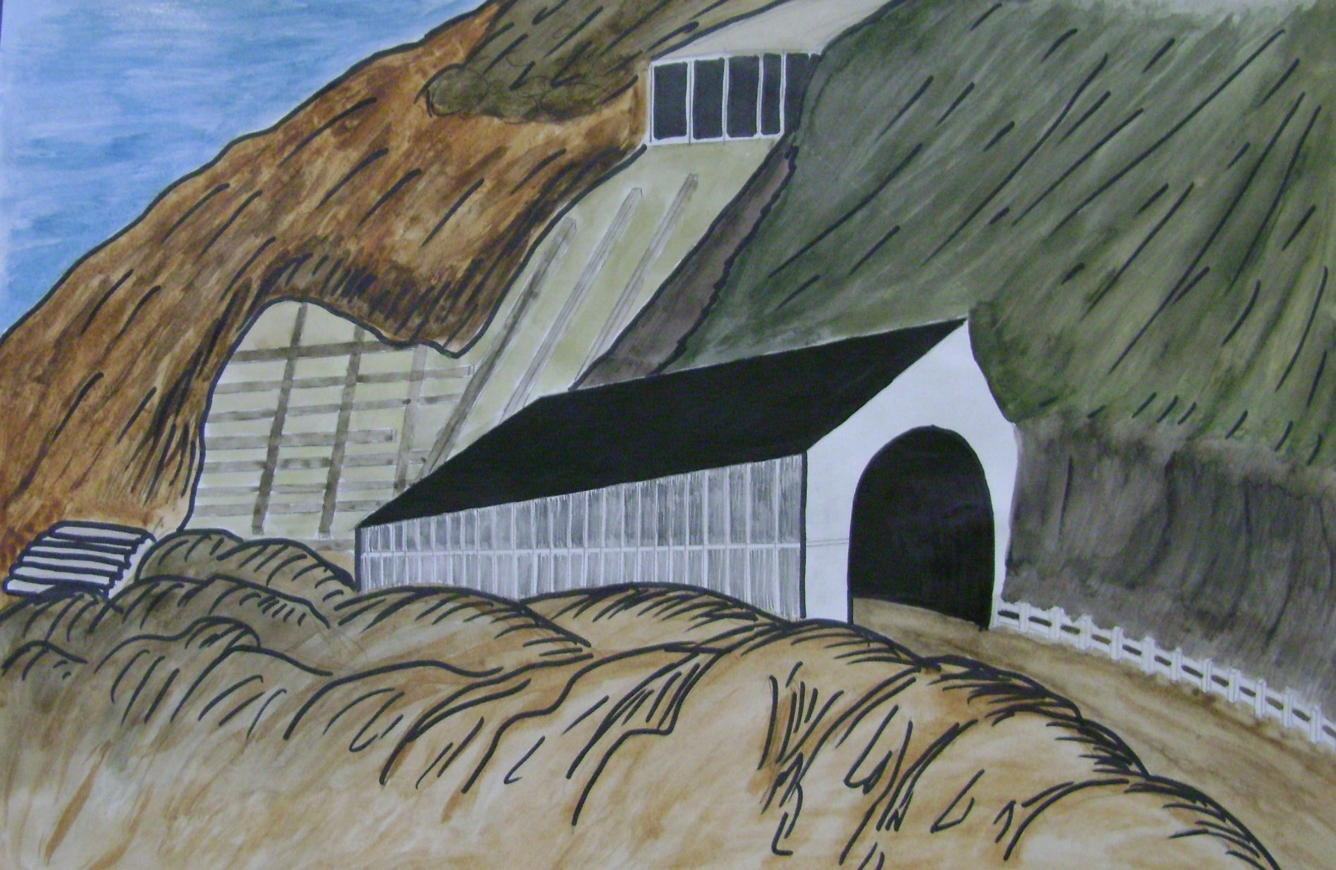
Рисунок 19 Галерея на опасном склоне
