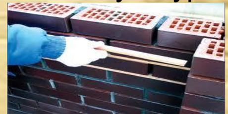
Вподрезку- кладка, при которой излишек раствора, выдавливаемый кирпичом при его укладке, подрезают кельмой заподлицо поверхностью кладки.
