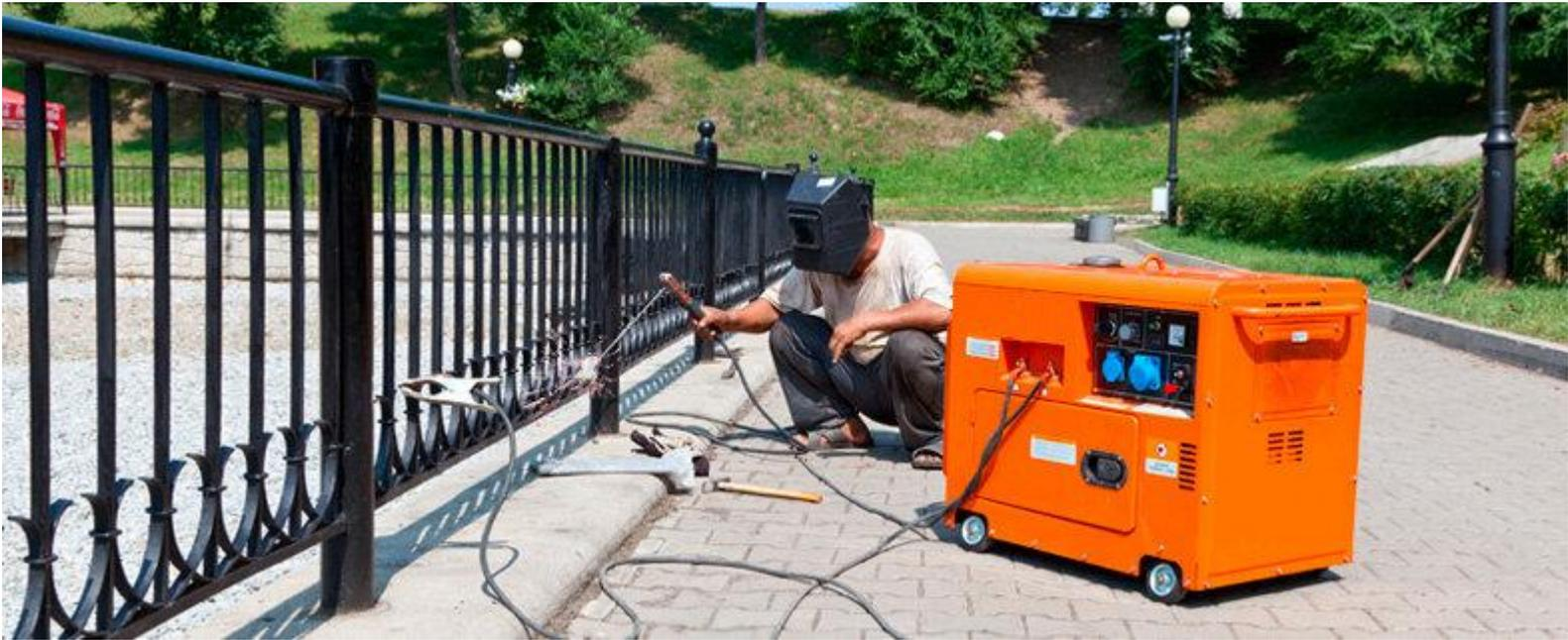
Термин «сварочный генератор» применяют к устройству особого типа, успешно сочетающему в своей конструкции *генератор со сварочным аппаратом*. Основное функциональное назначение этого агрегата заключается в выполнении сварочных работ в местах, не обеспеченных электрической энергией.
